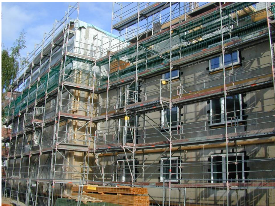
Foto aus der Bauphase: linke Seite Gebäude mit montierter Unterkonstruktion für die Fassade aus nachwachsenden Rohstoffen, rechte Seite Montage der neuen Fenster außen auf die Bestandsfassade
