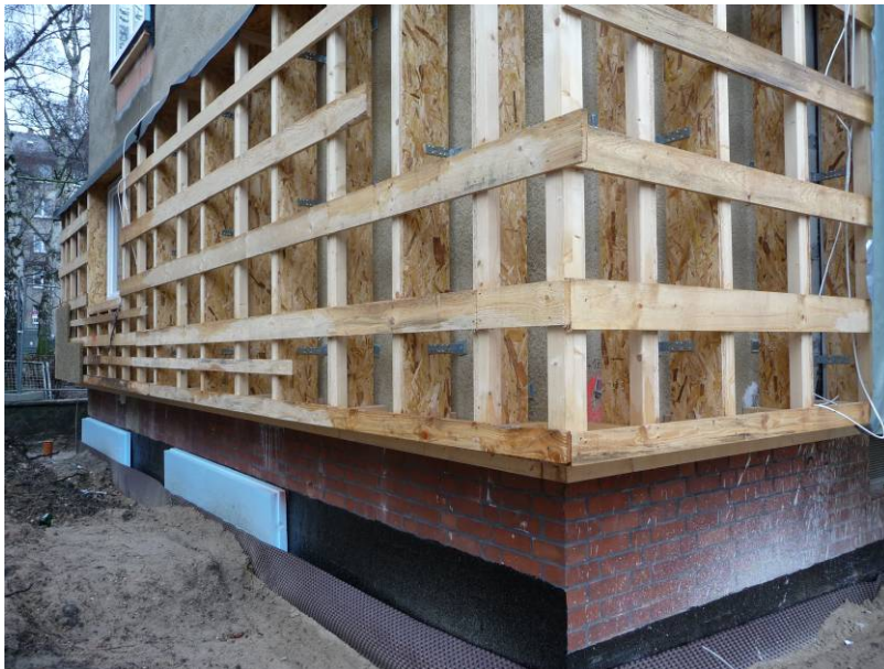
Musterfassade an einer Gebäudeecke ausgeführt
