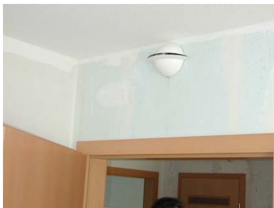
Abb. 2.8: Zuluftventil (Weitwurfdüse) über einer Innentür
