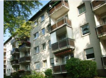
Abbildung 16: Gebäude der Effizienzklasse D
