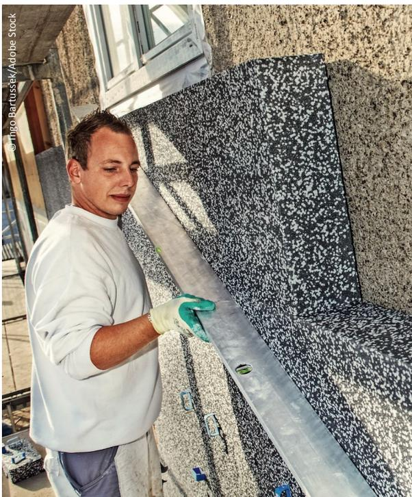
Ein Wärmedämmverbundsystem wird am Gebäude angebracht.
