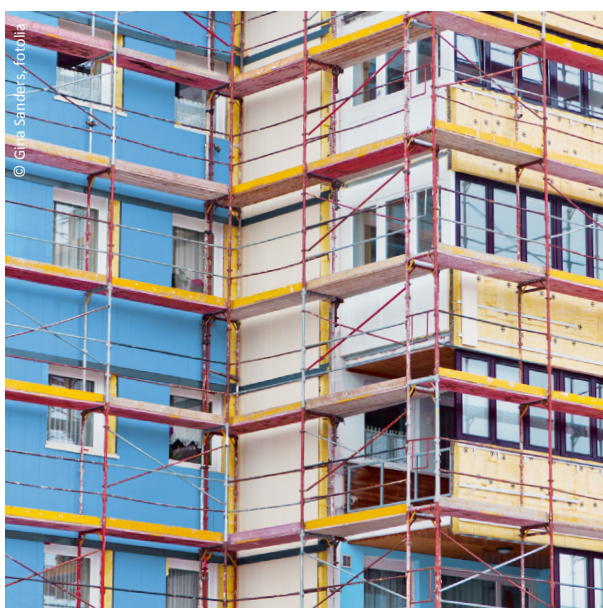
Steigerung der Energieeffizienz durch Außenwanddämmung
