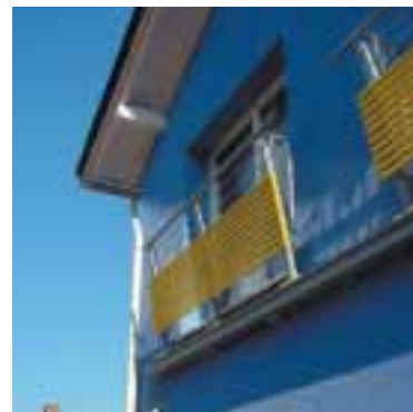
Im Zuge der Außenwanddämmung wurde auch der Dachüberstand angepasst.
