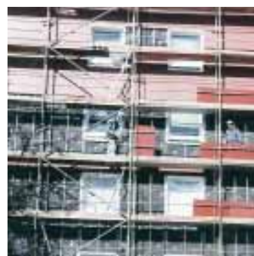
Die Stahlbeton-Außenwände wurden mit 8-12 cm verbesserter Mineralfaser gedämmt und anschließend mit Eternittafeln verkleidet.
