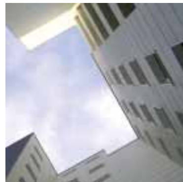
Die Fassade wurde mit großformatigen Eternittafeln verkleidet.
