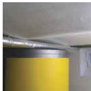
Unterseitige Dämmung der gewölbten Kellerdecke.
