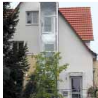
Über den im Eingangsbereich angebrachten Aufzug sind alle vier Ebenen des Hauses barrierefrei zu erreichen.
