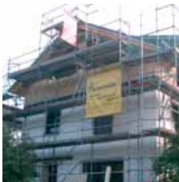
Umbau in Offenbach ZFH
