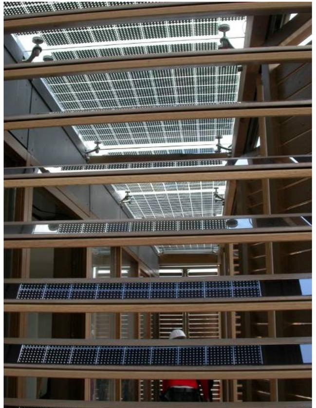
**Abb. 4: Blick in den Loggiabereich mit Solardach und Solarlamellen**
