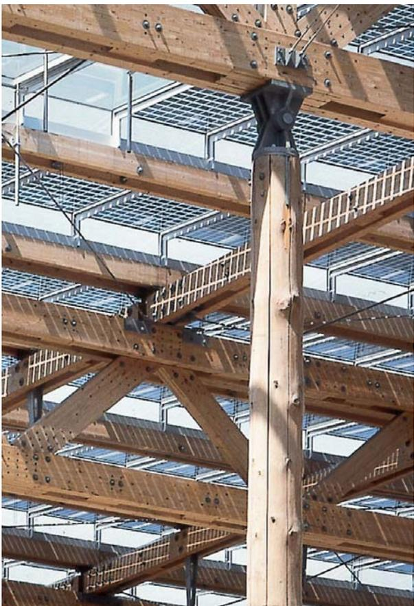
Verbindung der massiven Rundholzstützen mit der Dachkonstruktion
