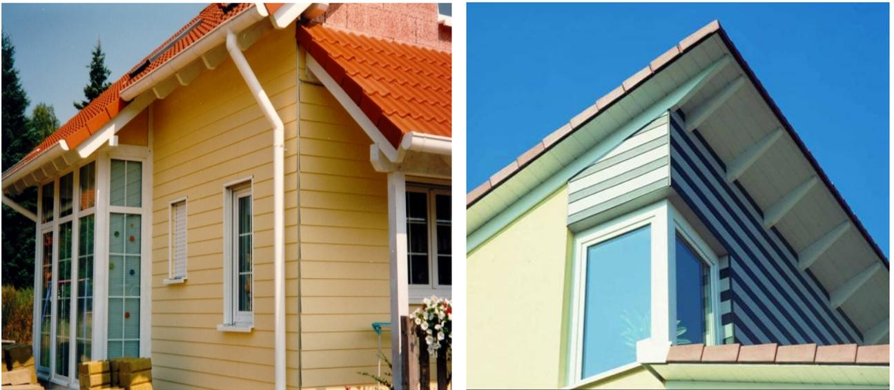
**Abb.1: Balkonverkleidungen und Fassadenelemente aus Holzwerkstoffen**
