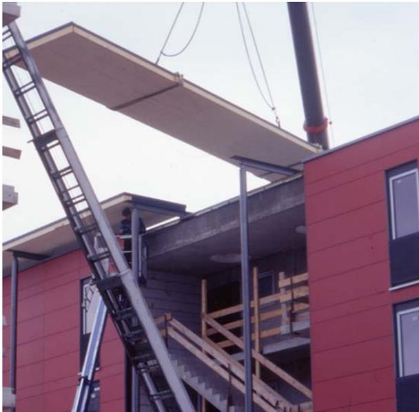
**Abb. 2: Einbau eines Fertigelementes**
