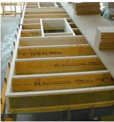
**FinnFrame Elemente** aus FinnJoist Stegträger für energieeffizientes Bauen. Das FinnFrame Bausystem umfasst die Bauteile FinnJoist-Stegträger und Kerto Rimboard für vielseitige Anwendungen im Wand-, Decken- und Dachbereich. Speziell beim energieeffizienten Bauen bietet FinnFrame allen Anwendern innovative und umweltschonende Lösungen. Tragfähigkeit, Haltbarkeit und Formstabilität zeichnen dieses Bausystem mit seinen Bestandteilen FinnJoist und Kerto Rimboard besonders aus.
