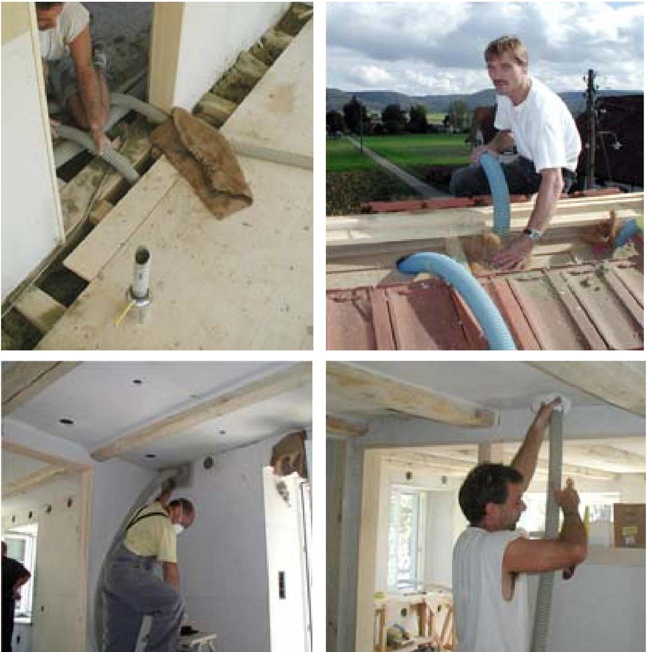
**Abb. 5 – 8: Einblasen des Dämmstoff Agricell auf der Baustelle**
