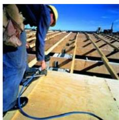
**Kerto-Furnierschichtholz** ist ein außergewöhnlich fester Holzwerkstoff aus finnischer Fichte. Durch die Verarbeitung zu Furnierschichtholz wird das Holz vergütet, indem die natürlichen Fehlstellen reduziert und verteilt werden. Die Festigkeiten werden erhöht, Schwind und Quellformung vermindert und es können andere Querschnittsformen als mit Schnittholz hergestellt werden. (s. [www.kerto.de](http://www.kerto.de))
