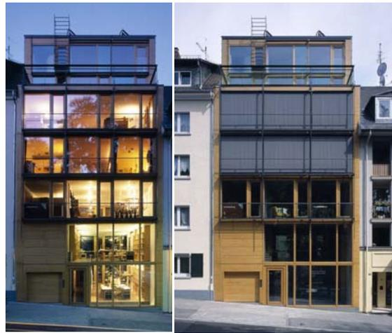
**Abb. 4: Bürogebäude A-Z-Architekten mit Fassadenelementen in Holzfertigteilbauweise**
