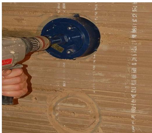
Mit Radiesenfräser werden die Nuten der Platten miteinander verbunden.
