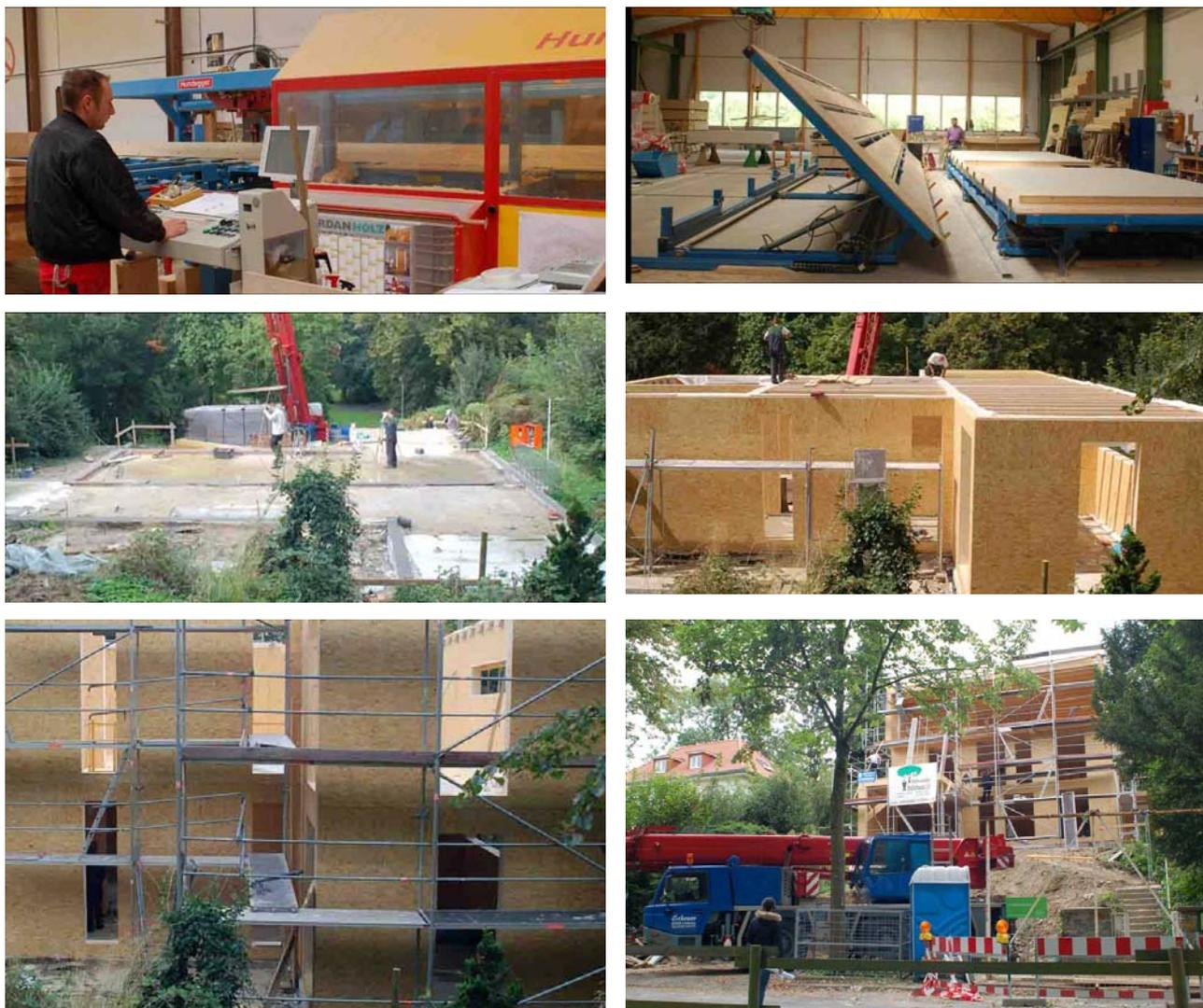
**Abb. 7: Herstellung des Holzhauses, Fertigung in der Halle und Aufbau**
