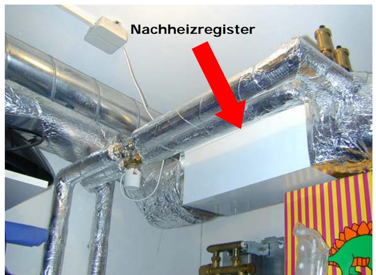
**Abb. 4: Nachheizregister als aktive Heizung im Passivhaus**
