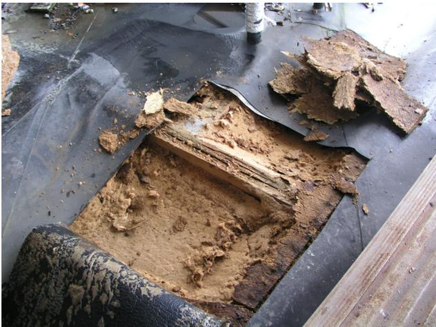
**Abb. 9: Schaden durch Luftundichtigkeit und Hohlräume, in die zusätzlich feuchtwarme Luft durch mit Überdruck betriebene Lüftungsanlage eingetrieben wurde**
