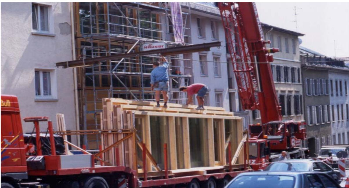
**Abb. 5: Anlieferung und Montage der Fassadenelemente**
