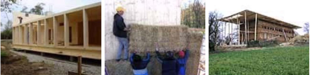
So wurden z.B. im Rahmen des Projekts **„Wandsysteme aus nachwachsenden Rohstoffen“** (GrAT in Zusammenarbeit mit IBO/Österreichisches Institut für Baubiologie- und Ökologie, Wien 2001) sämtliche technischen Grundlagen für ein Holzständerwandsystem mit Strohdämmung erarbeitet und der Baustoff Stroh sowie der von den Architekten Scheicher entwickelte Wandaufbau bezüglich ihres Brandverhaltens und ihrer Wärmeleitfähigkeit geprüft und zertifiziert.
