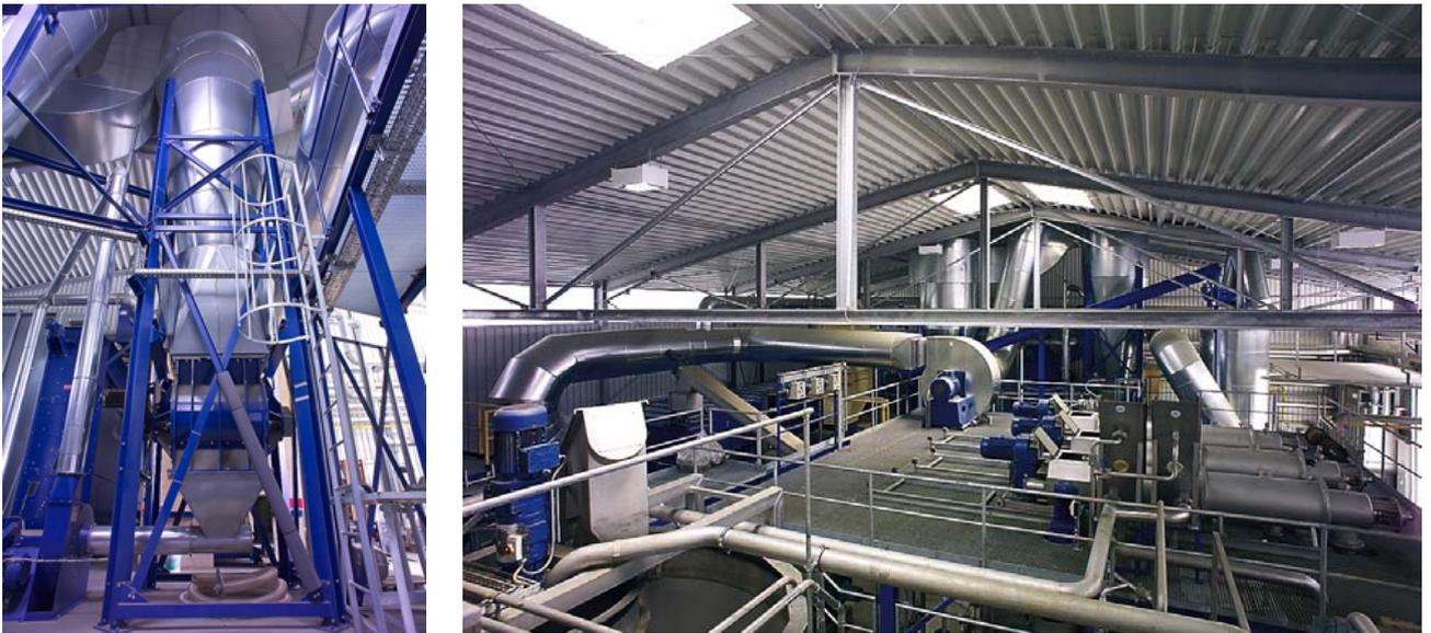
**Abb. 3 und 4: Die Anlage im Werk Brensbach: Silo und Trocknungsanlage**
