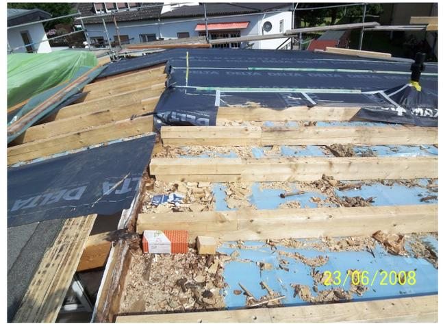
**Abb. 8: Schäden durch Luftundichtigkeiten in einer nicht belüfteten Konstruktion mit so erheblichem konvektiven Wasserdampfeintrag, dass auch die sommerliche Austrocknung nicht ausreicht hat**
