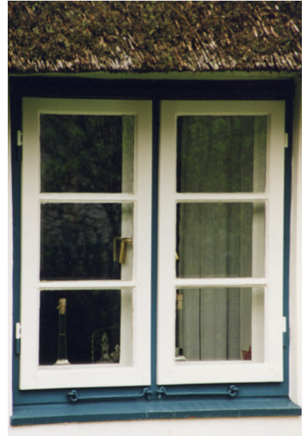
Kastenfenster in einem Haus in Norddeutschland
