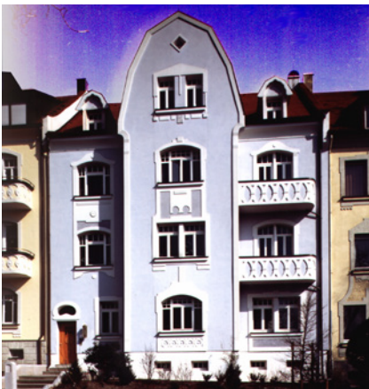
Auch dieses historische Gebäude wurde mit einem Wärmedämmverbundsystem saniert.
