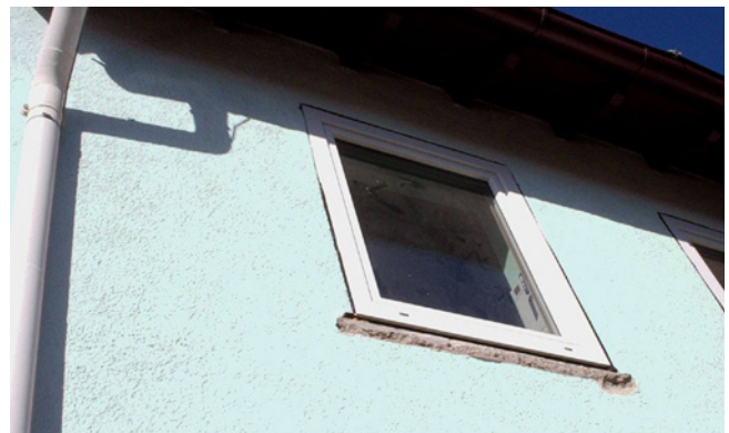
So ist die Fassade ideal für das Aufbringen der Dämmung vorbereitet: Die neuen Wärmeschutzfenster sind außenbündig eingebaut und die Kanten der alten Fensterbänke wurden abgestemmt.
