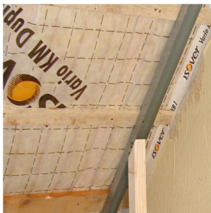
Luftdichtung unter den Sparren dicht einbauen
