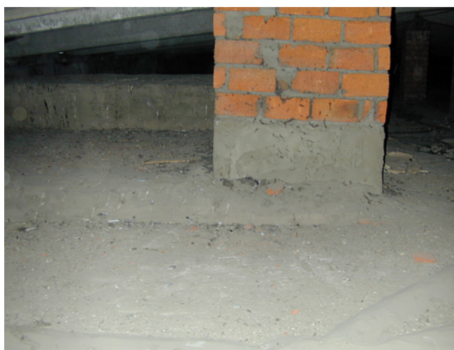
Dachboden: Zugänglich und nicht ausbaubar, also hätte er laut Energieeinsparverordnung schon bis zum 31.12.2006 auf einen U-Wert von 0,3 \text{ W}/(\text{m}^2\text{K}) verbessert werden müssen. 20 cm Dämmstoff sind hier leicht ausgerollt.
