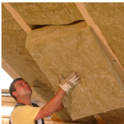
Dämmstoff sparrenhoch einbauen = 12 - 14 cm
