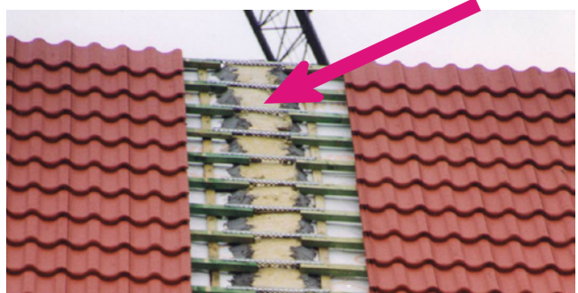
Die Dämmung und die Dachlattung über einer „Brandwand“ muss aus feuerfestem Material bestehen.
