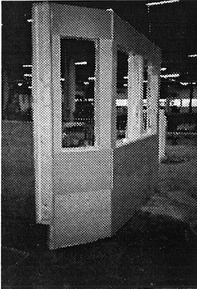
**Abb. 34:** Fensterelement (Erker) vor dem Anbringen der Außenverkleidung und Einbau der Fenster
