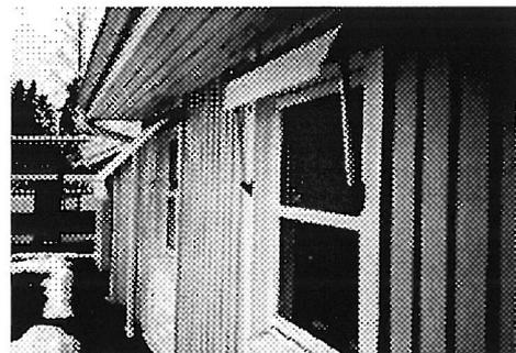
Abb. 23: Sonnenschutzvorrichtung
