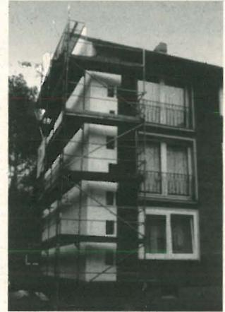
*Bild 8:* Anbringung Wärmedämmverbundsystem: 12 cm sind beim Altbau die optimale Dämmschichtdicke für die Außenwand
