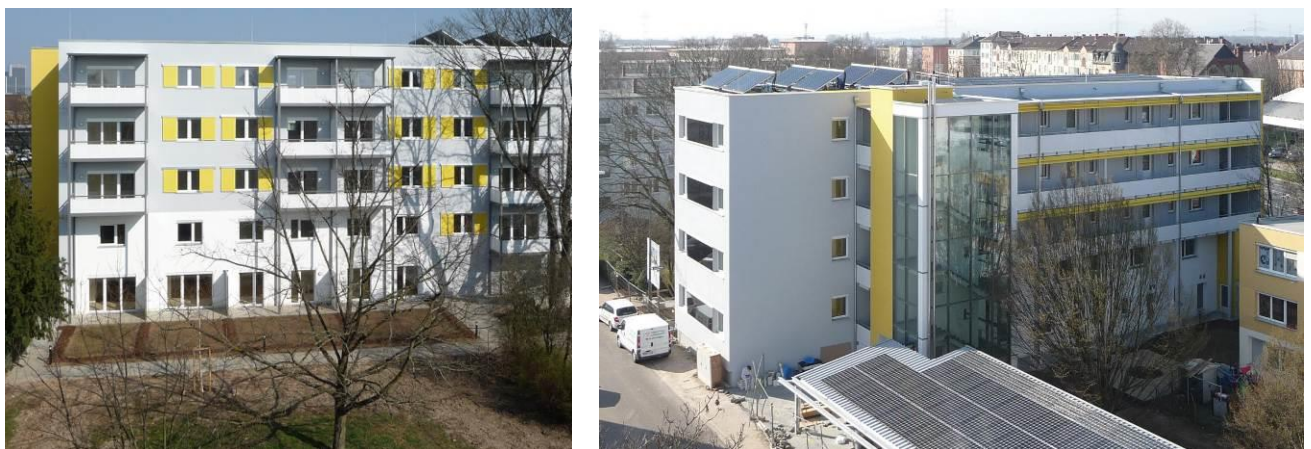
Abbildung 1: Ansichten des Gebäudes von der West- und Südostseite
