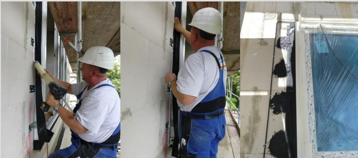
**Bild 15: Ausführung des luftdichten Anschlusses der Fenster in der Bauphase**
