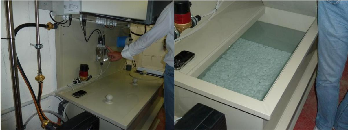
**Bild 20: Details der Wasserbehandlungsanlage Diaphragmalyse: Dosieranlage (links), Solebehälter mit Salztabletten (rechts)**
