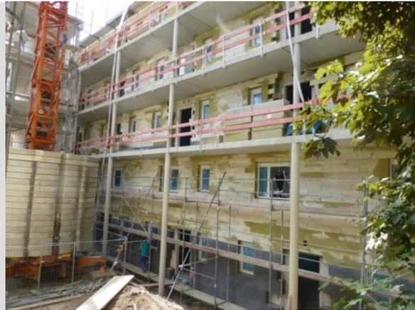
**Bild 13:** Dämmung auf der Ostseite: EG EPS-Dämmung, im Bereich der Laubengänge Mineralwolle; oben: Planungsstand September 2012; unten: Ausführung September 2013
