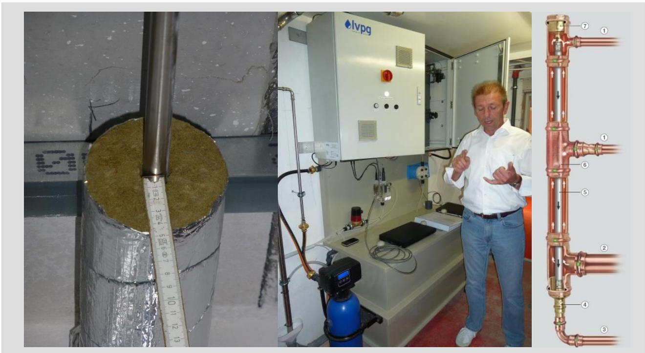
**Bild 18:** Reduktion des Wärmebedarfs für Warmwasser: Erhöhte Dämmung der Rohrleitungen Warmwasser 250 % nach EnEV (links), Einsatz einer Diaphragmalypse (Mitte) und Rohr-in-Rohr-System (rechts)
