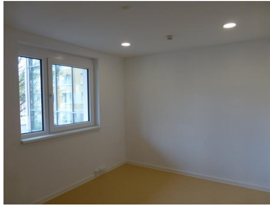
Bild 15: Energieeffiziente LED-Beleuchtung in den Räumen
