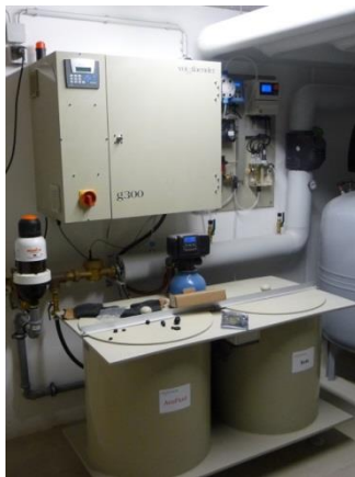
Bild 13: Diaphragmalyse (links) und Pufferspeicher Wärme (rechts)
