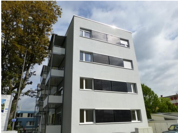
Bild 7: Südansicht des Gebäudes mit fassadenintegrierter Photovoltaik
