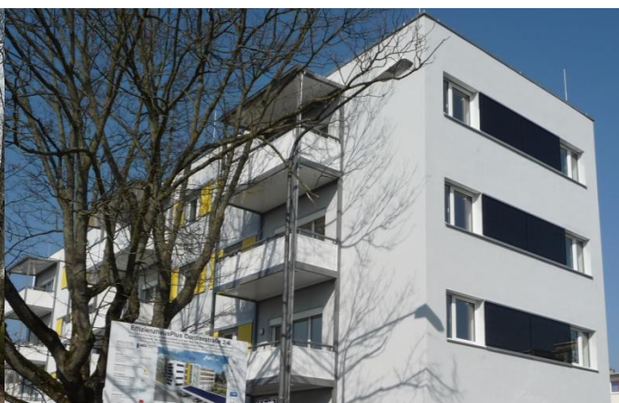
Bild 2: Südansicht des Gebäudes
