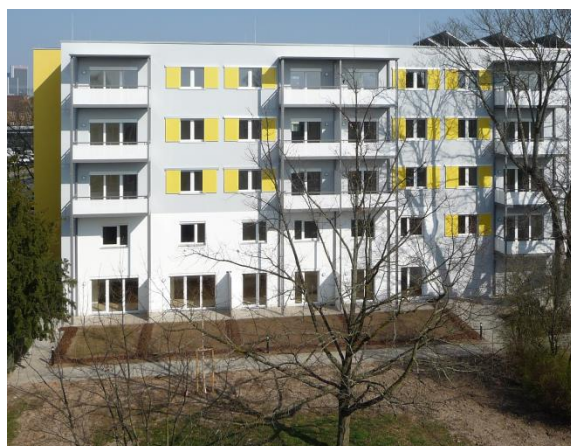
Bild 1: Westansicht des Gebäudes
