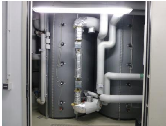
Bild 13: Diaphragmalyse (links) und Pufferspeicher Wärme (rechts)
