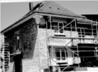
Abschlagen des alten Putzes
