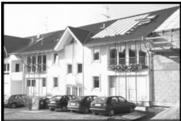
Bild 9: Das Land Hessen förderte Ende der Achtziger bzw. Anfang der Neunziger Jahre den Bau von 30 Niedrigenergiehäusern. Die gewonnenen praktischen Erfahrungen sind in verschiedenen Publikationen dokumentiert (Foto: IWU).
