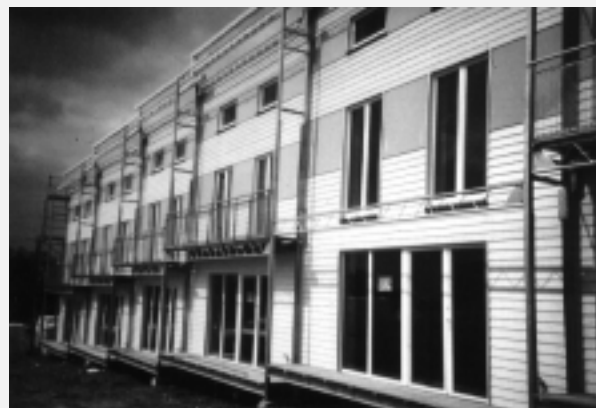
Bild 13 Erste kostengünstige Passivhäuser in Wiesbaden-Dotzheim (Foto: IWU)
