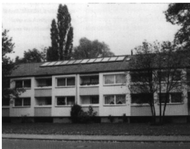
Bild 8: Die CO 2 -Emissionen von 26 Mietshäusern konnten in Hannover durch Verbesserung des Wärmeschutzes und der Heizungsanlage um ca. 50 % reduziert werden. (Foto: Stadtwerke Hannover)
