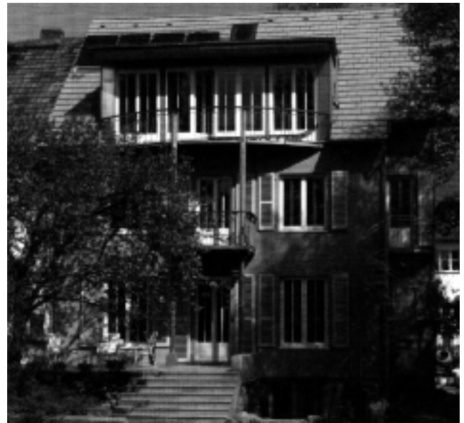
Bild 18: Dieser Darmstädter Altbau wurde durch eine energetische Modernisierung auf Niedrigenergiehaus-Niveau gebracht. (Foto: IWU)
