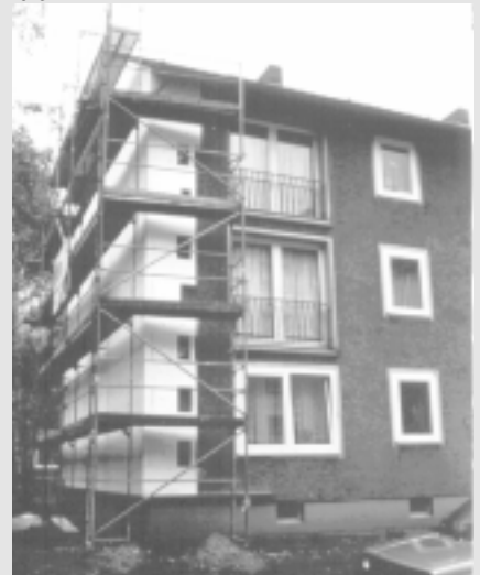
Anbringen der Wärmedämmung
