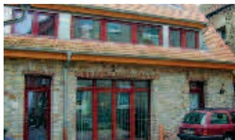
Das Bruchsteinmauerwerk wurde wieder verwendet. Passivhausfenster, umfangreiche Innendämmung, hohe Dichtigkeit und effiziente Lüftung ergeben einen exzellenten Wärmeschutz auf Passivhausniveau.
