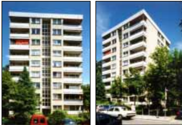
Ansicht des Gebäudes vor der Sanierung
