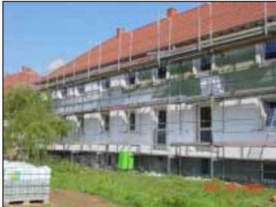
Ansicht des Gebäudes von der Hofseite beim Anbringen des Wärmedämmverbundsystems
