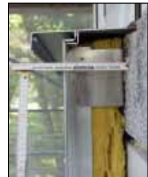
Überdämmung der Balkonbrüstung mit Mineralfaser (Brandschutz)
