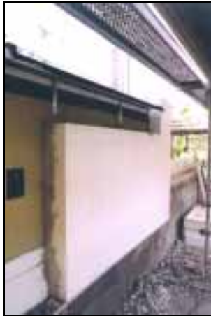
Die Dämmung der Außenwand ist bis über die Kellerdecke gezogen
