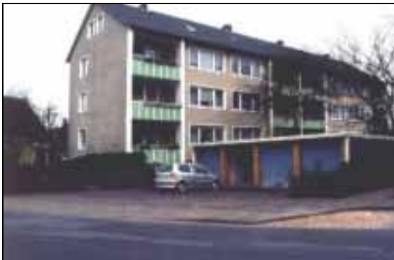
Ansicht des Hauses von Süden vor der Sanierung
