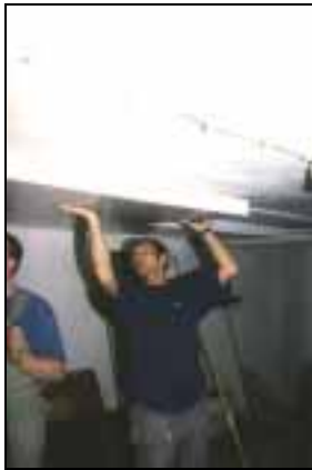
Montage der Dämmplatten an der Kellerdecke
