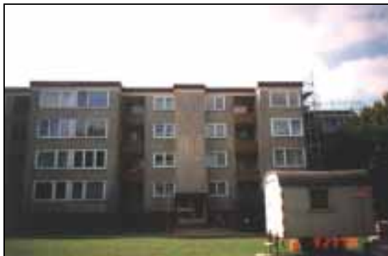
Eingangsseite der Gebäude vor der Sanierung
