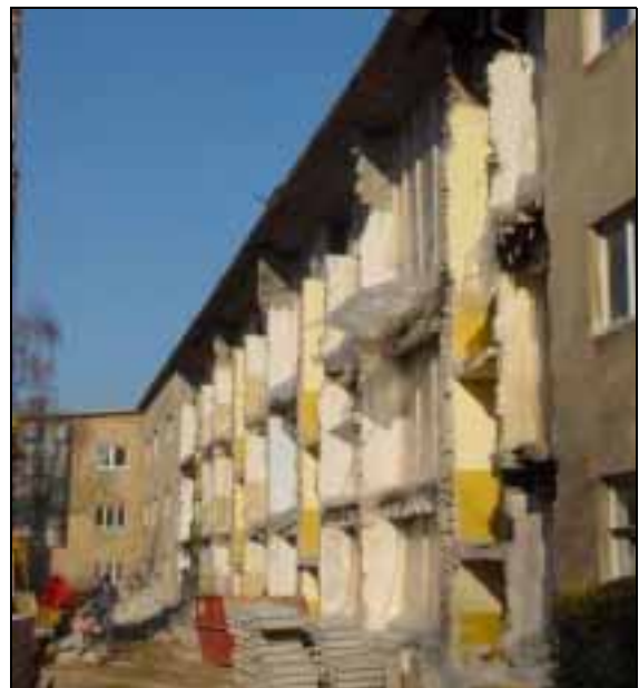
Ansicht nach Abbruch der Fassade
