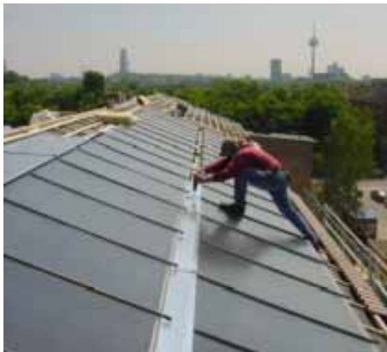
Montage der Solaranlage auf dem Dach des Gebäudes
