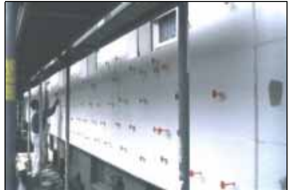
Ansetzen der Dämmstoffdübel
