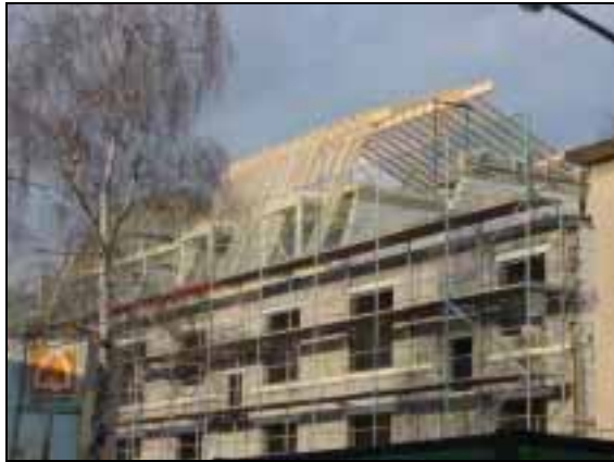
Errichtung des neuen Mansarddaches
