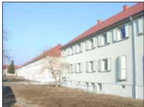
Die Gebäude nach Abschluss der Außenarbeiten auf der Hofseite
