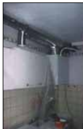
Montage des Lüftungsgeräts in der Küche
