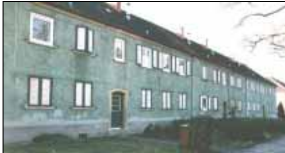
Straßenansicht vor der Modernisierung
