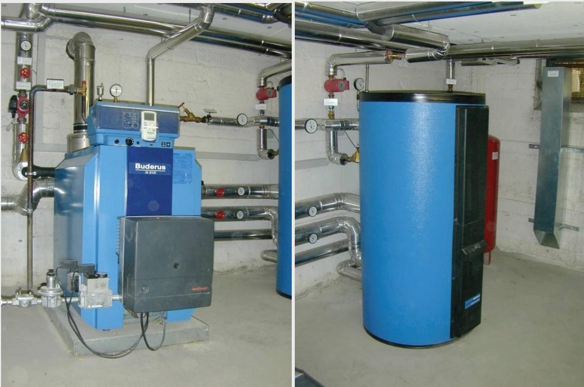
Die Leitungslängen der Heizwärme- und Warmwasserverteilung wurden aus den Gebäudeplänen (1:50) abgeschätzt, die Längenermittlung ist in Abschnitt 0 dokumentiert. Vom Heizkeller aus wird die Wärme horizontal im Keller verteilt und anschließend Steigsträngen zu den einzelnen Wohneinheiten verlegt, wo in den Wohnungen neue Heizkörper montiert wurden. Die Dämmung der Leitungen erfolgte nach den Vorgaben der zum Ausführungszeitpunkt geltenden Heizungsanlagenverordnung.
