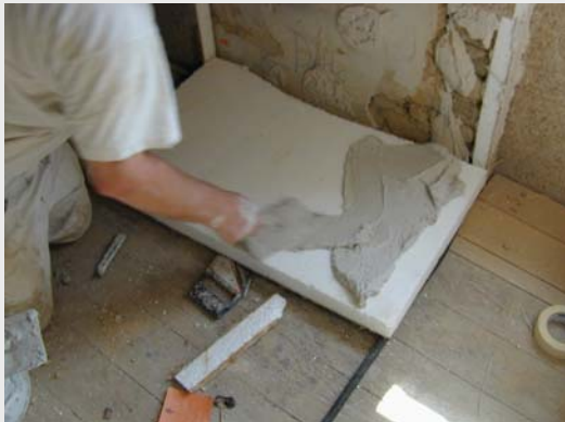
Bild 10: Links: Vorbereitung der Dämmplatten für das Ankleben an die Wand, Rechts: Unterhalb eines Fensters verlegte Dämmplatten
