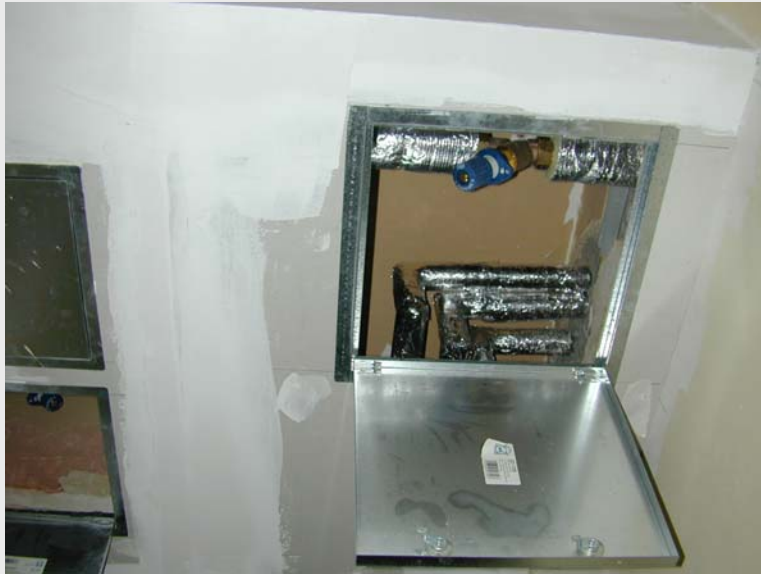
Bild 21: Wärmeverteilungsleitungen in der abgehängten Decke des Erdgeschosses / Verlegung der vertikalen Steigstränge der Heizwärmeverteilung
