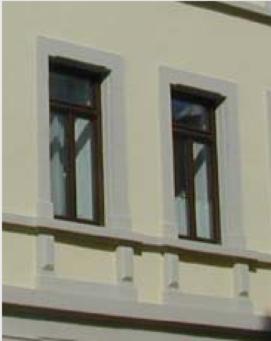
Bild 16: Die neuen Fenster von außen und innen
