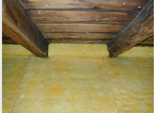
Bild 19: Kehlbalkendecke nach Durchführung der Dämmmaßnahmen
