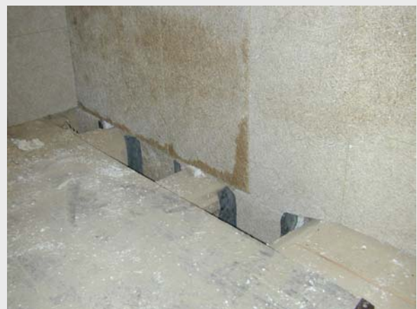
Bild 36: linkes Bild: Zum Ausstopfen der waagerechten Fuge wurde die unterste Dämmplatte im Raum vorübergehend wieder entfernt. rechtes Bild: Gesamtsituation nach Abkleben der Fugen und Anschlüsse.
