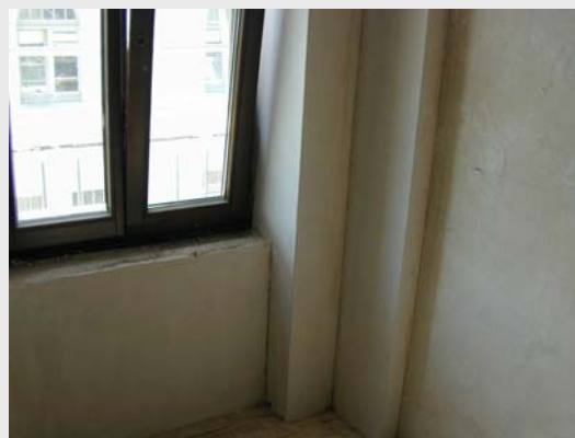
Bild 11: Innendämmung in der Fensterlaibung und an der anstoßenden Innenwand; links vor, rechts nach dem Verputzen
