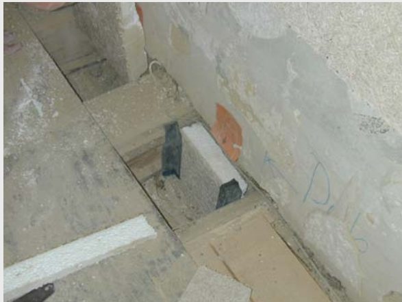
Bild 36: linkes Bild: Zum Ausstopfen der waagerechten Fuge wurde die unterste Dämmplatte im Raum vorübergehend wieder entfernt. rechtes Bild: Gesamtsituation nach Abkleben der Fugen und Anschlüsse.
