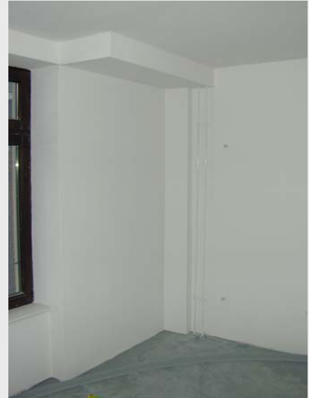
Bild 21: Wärmeverteilungsleitungen in der abgehängten Decke des Erdgeschosses / Verlegung der vertikalen Steigstränge der Heizwärmeverteilung
