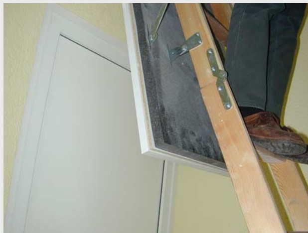
Bild 20: Luke zur Kehlbalkendecke mit Dämmauflage und umlaufender Dichtung
