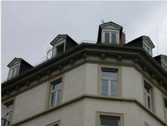
Bild 4: Gebäude vor der Modernisierung: Ansicht Dachgauben und Dachgeschosswohnung
