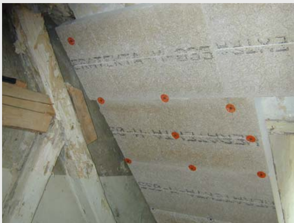
Bild 17: Dämmung der Dachschrägen und Dachgauben im Obergeschoss
