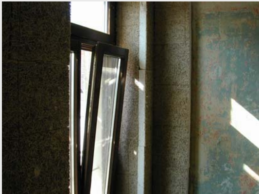
Bild 11: Innendämmung in der Fensterlaibung und an der anstoßenden Innenwand; links vor, rechts nach dem Verputzen
