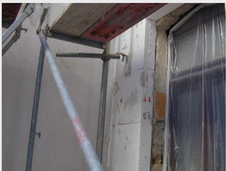
Bild 14: Detailansicht im Fensterbereich vor Anbringung der Laibungsdämmung
