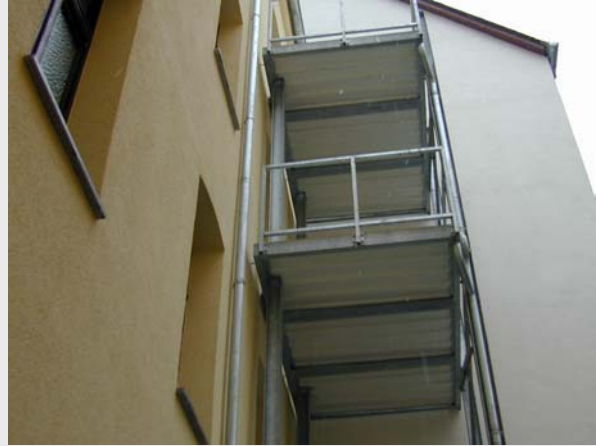
Bild 15: Hoffassade nach der Dämmung, rechts die freistehende Balkonkonstruktion
