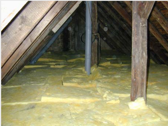
Bild 19: Kehlbalkendecke nach Durchführung der Dämmmaßnahmen
