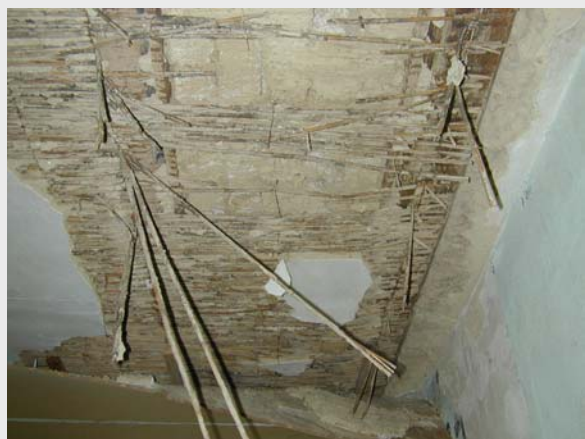
Bild 5: Untersicht einer geöffneten Holzbalkendecke mit Bimsstein-/Lehmschlag-Füllung Die Strohmatte dienten als Putzträger, Putzreste sind noch zu erkennen.
