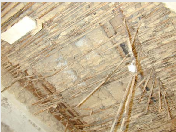
Bild 5: Untersicht einer geöffneten Holzbalkendecke mit Bimsstein-/Lehmschlag-Füllung Die Strohmatte dienten als Putzträger, Putzreste sind noch zu erkennen.
