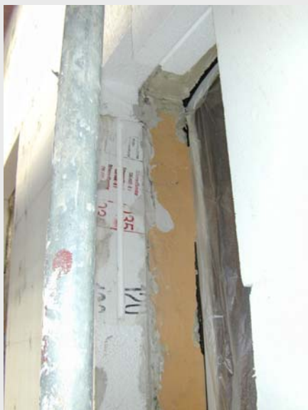
Bild 14: Detailansicht im Fensterbereich vor Anbringung der Laibungsdämmung
