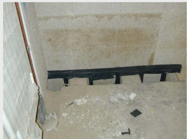
Bild 36: linkes Bild: Zum Ausstopfen der waagerechten Fuge wurde die unterste Dämmplatte im Raum vorübergehend wieder entfernt. rechtes Bild: Gesamtsituation nach Abkleben der Fugen und Anschlüsse.
