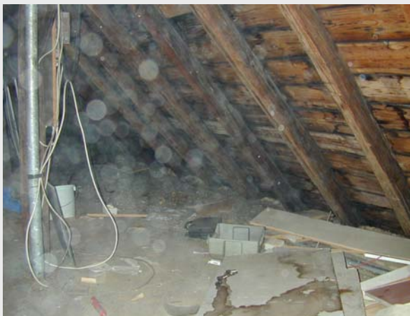
Bild 7: Gebäude vor der Modernisierung: Details der Elektro- und Gasinstallation
