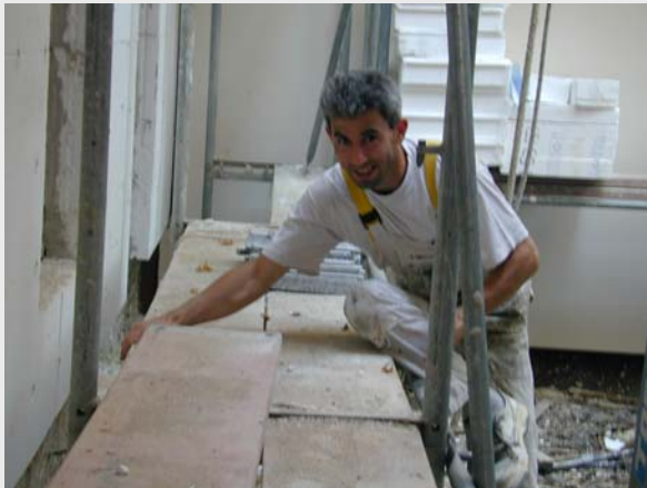
Bild 13: Anbringung des Wärmedämmverbundsystems an der Hoffassade
