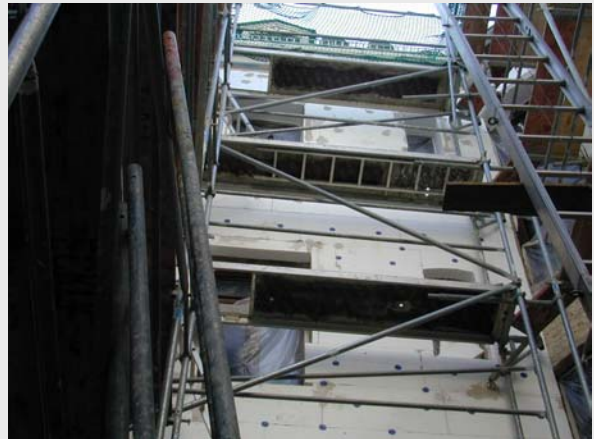
Bild 13: Anbringung des Wärmedämmverbundsystems an der Hoffassade
