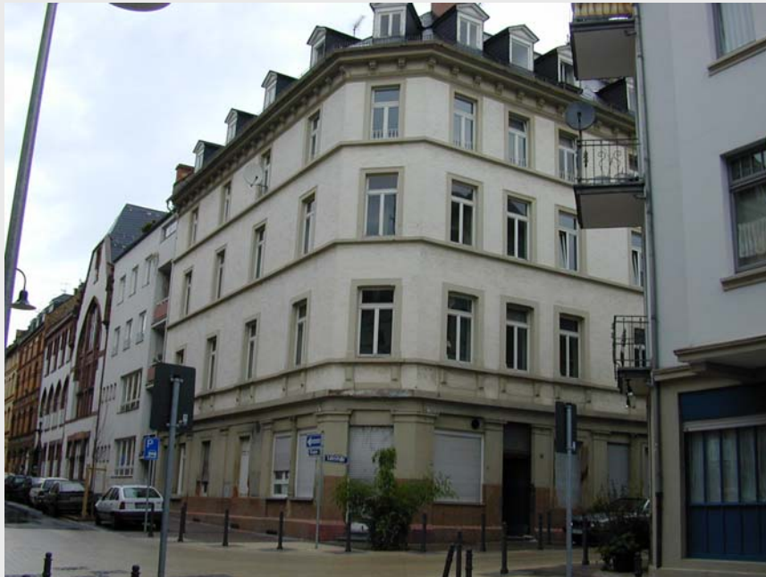
Bild 1: Gründerzeithaus Lehrstraße 2, Wiesbaden, Straßenfassade vor der Modernisierung
