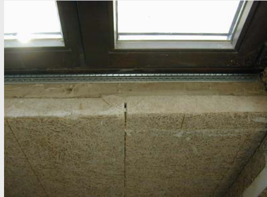
Bild 10: Links: Vorbereitung der Dämmplatten für das Ankleben an die Wand, Rechts: Unterhalb eines Fensters verlegte Dämmplatten
