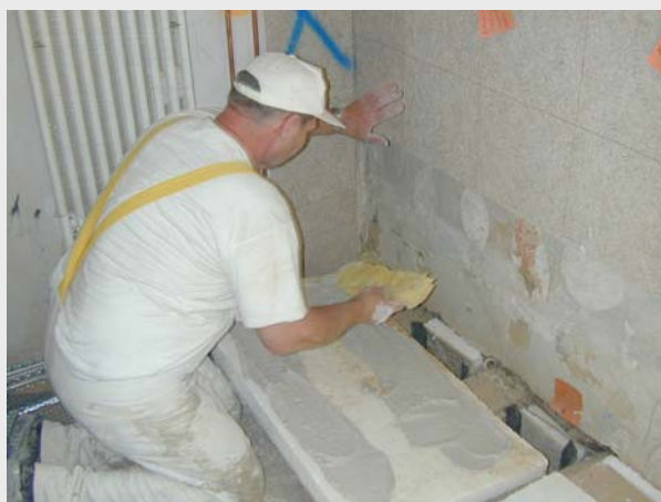
Bild 36: linkes Bild: Zum Ausstopfen der waagerechten Fuge wurde die unterste Dämmplatte im Raum vorübergehend wieder entfernt. rechtes Bild: Gesamtsituation nach Abkleben der Fugen und Anschlüsse.
