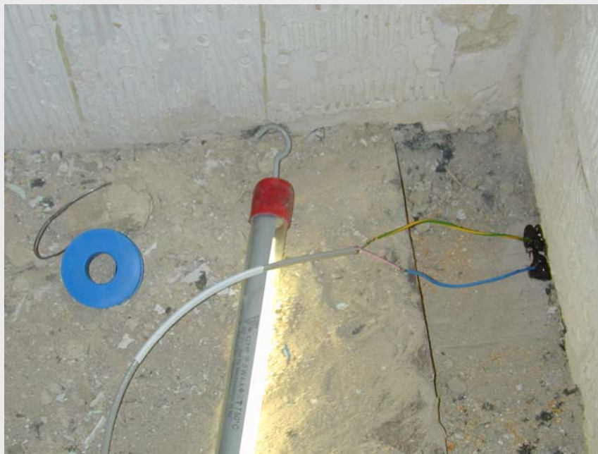
Bild 33: mit dem Messkabel verlötetes Sondenpaar zur Feuchtemessung (Messstelle 5) Die beiden Kabel wurden später noch durch einen Schrumpfschlauch geschützt, welcher vorher über das Kabel gezogen wurde und hier links von der Lampe weiß sichtbar ist.
