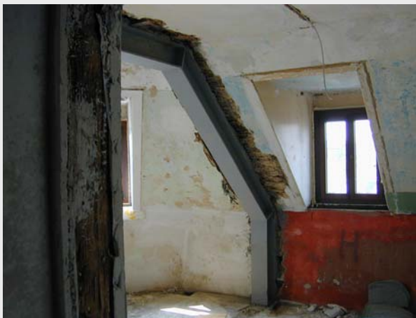
Bild 18: Dachräume mit Stahlträgern vor und nach Durchführung der Maßnahmen
