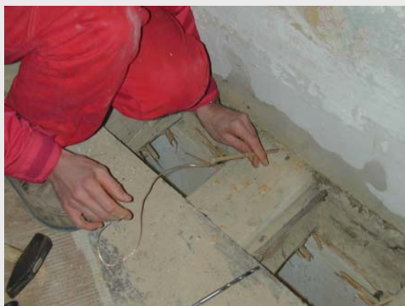
Bild 29: Einbringen der Messsonde in das linke Bohrloch
