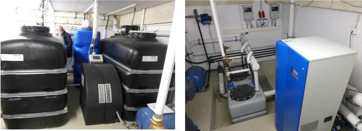
Im Sommer 2020 wurde die Grauwasseranlage um einen zusätzlichen Filter erweitert, um die Aufbereitungsleistung zu erhöhen (siehe Bild 12 rechts).
