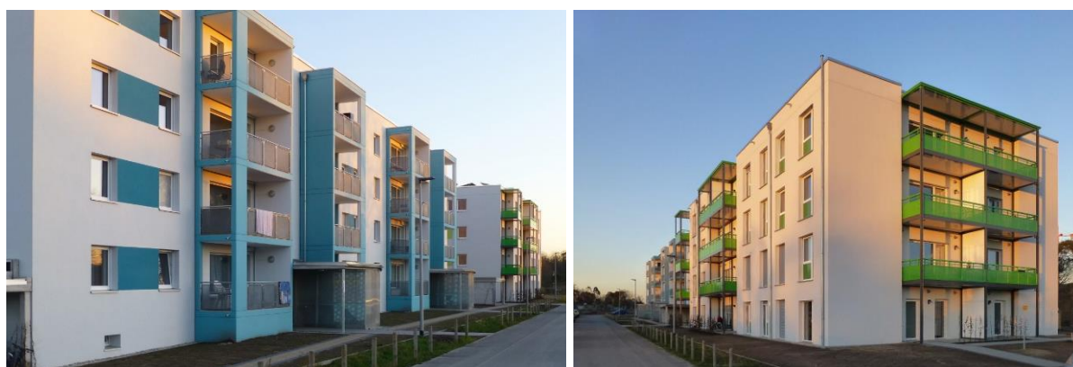
Bild 1: Modernisiertes Bestandsgebäude (links) und Neubau (rechts)
