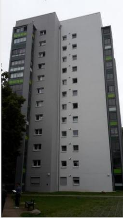
Das hier begangene Gebäude von 1965, 2016 energetisch modernisiert. Je Geschoss sind die zwischen zwei Fensterstürzen angeordneten Zu- und Abluftöffnungen der Lüftungsanlage mit WRG zu erkennen
