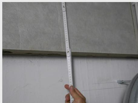
Flankendämmung von 60 cm Höhe umlaufend an den Kelleraußenwänden zur Reduzierung der Wärmebrückenwirkung
