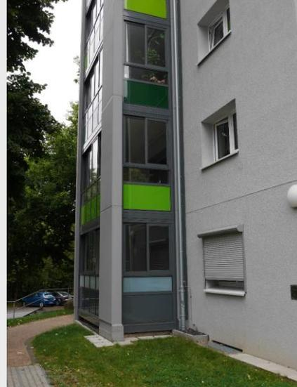
Wärmedämmverbundsystem, im Erdgeschoss vorgesetzte Rolläden. geschlossene Veranden an Stelle der früheren Balkone
