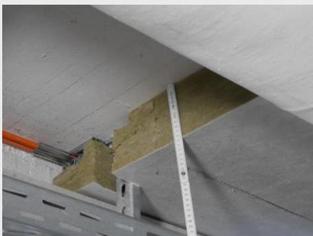
Eine der wenigen Lücken in der Kellerdeckendämmung dient zur Überprüfung der Dämmstärke
