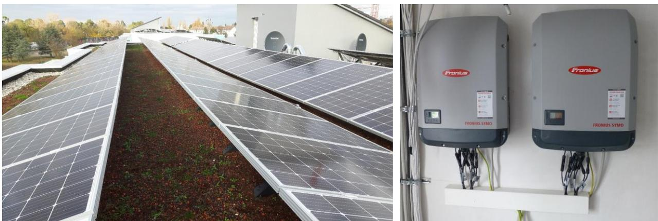
Die installierte PV-Leistung liegt beim Bestandsgebäude bei 40,9 kWp, beim Neubau bei 43,3 kWp (siehe Tab. 2). Die leistungsstärkeren Module mit 310 W<sub>p</sub>, die beim Bestandsgebäude verwendet wurden, waren bei der Installation auf dem Neubau nicht lieferbar – deswegen wurden auf dem Neubau 305 W<sub>p</sub>-Module installiert. Beide Anlagen besitzen jeweils zwei Wechselrichter, die jeweils im oberen Bereich des Treppenhauses zum Dachausgang innerhalb der thermischen Hülle montiert wurden.
