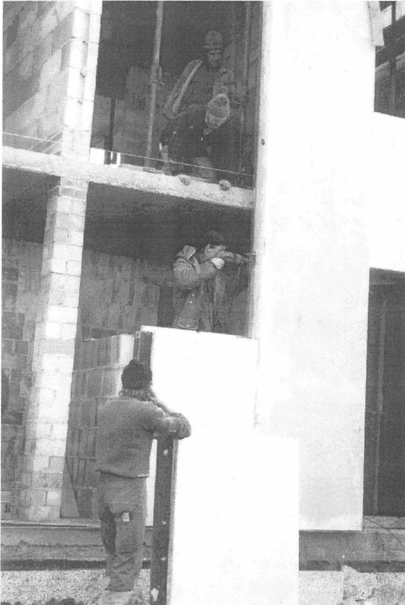
Abb.6) Die Außenfassade während der Fertigung an der Baustelle. Die vorgefertigten Außenwandelemente reichen über zwei Etagen. Im Fensterbereich werden gerade die Brüstungselemente angebracht. (Foto: Fingerling)
