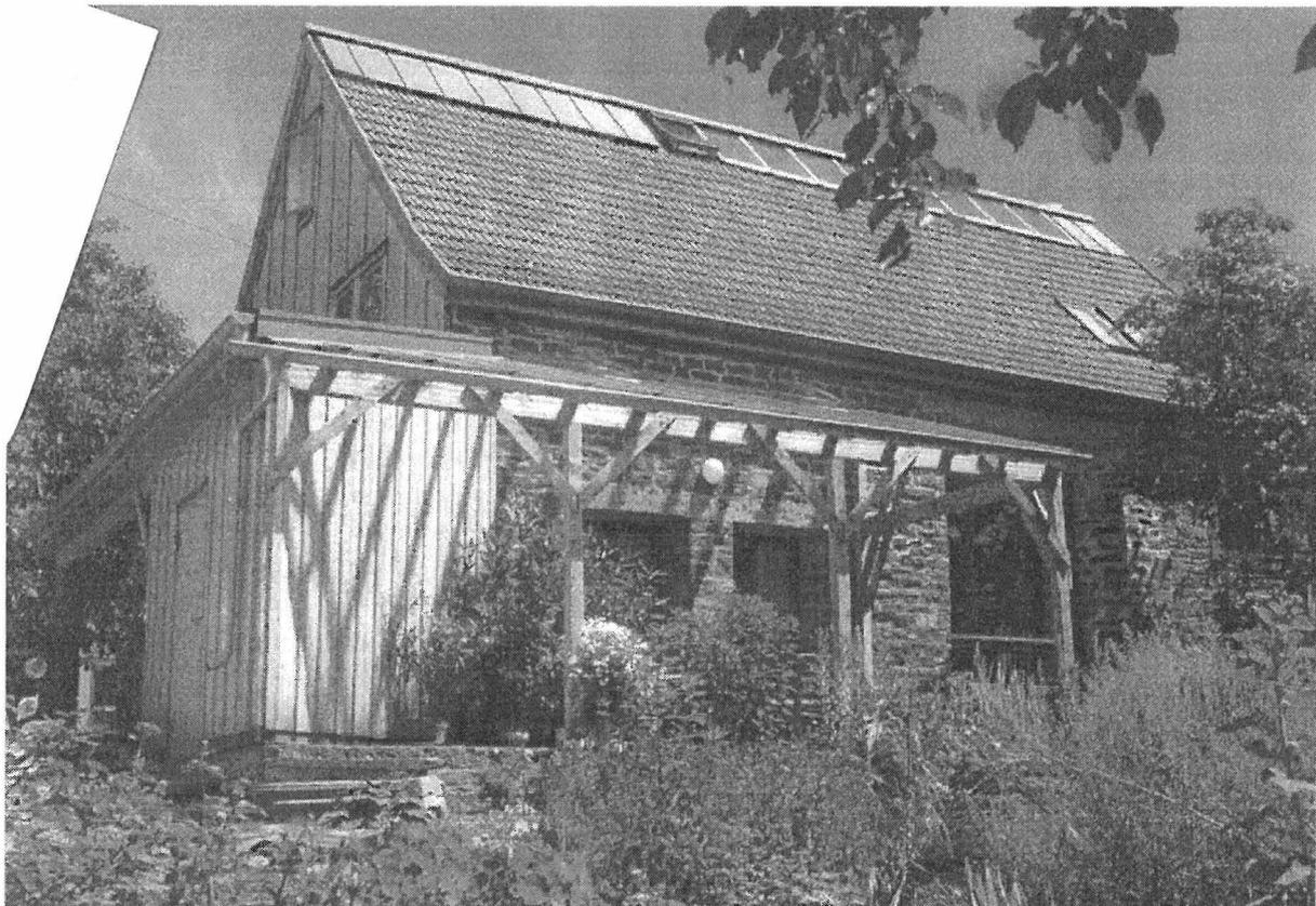
Abb.5) Die Westansicht des Einfamilienhauses Schwab in Mosbach. In das historische Scheunengebäude wurde ein Niedrigenergiehaus in Holzrahmenbauweise eingebaut. Vor allem über den verglasten First gelangt viel Licht in die Innenräume.
