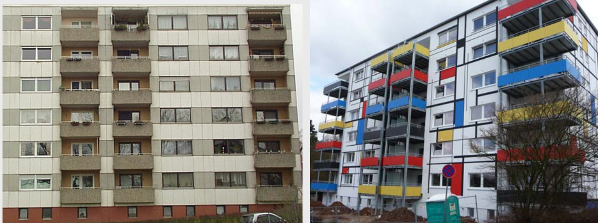
Abbildung 5.3-1: Fassadenansicht des Gebäudes vor und nach der Sanierung
