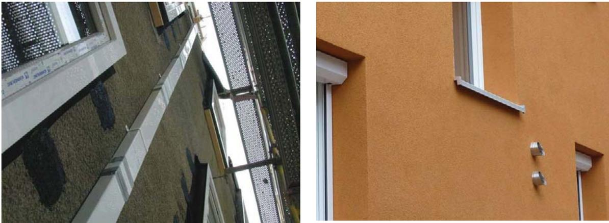
**Abb. 4-11: Links: Montage des Abluftkanals auf der Außenwand innerhalb der Wärmedämmung, rechts: Frischluft- und Fortluftdurchführung an der Außenwand**
