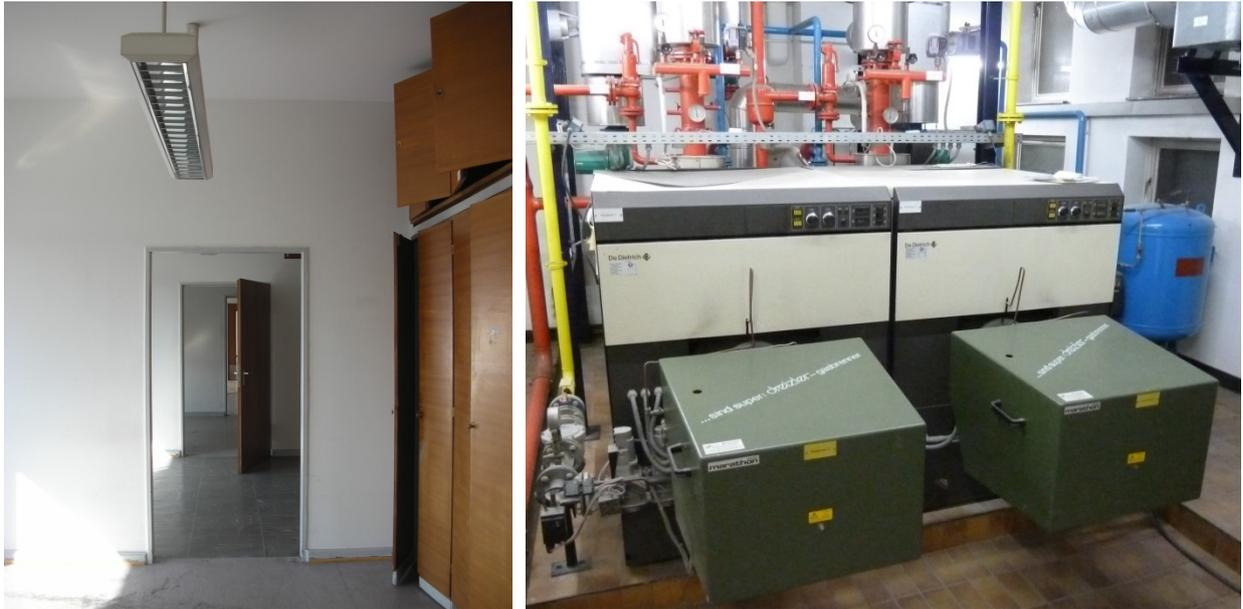
Abbildung 2: Links, ein Blick in die Büroräume vor der Sanierung; rechts die beiden Niedertemperatur-Gaskessel mit einer Nennleistung von zusammen einem Megawatt.
