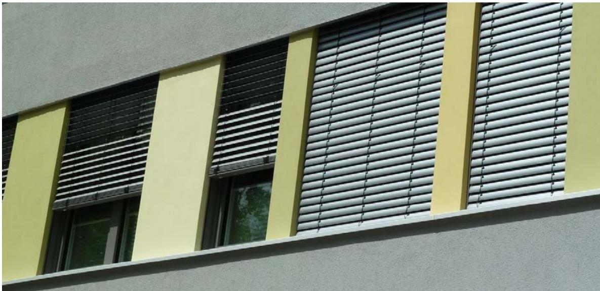
Abbildung 5: Sonnenschutz an der Südfassade
