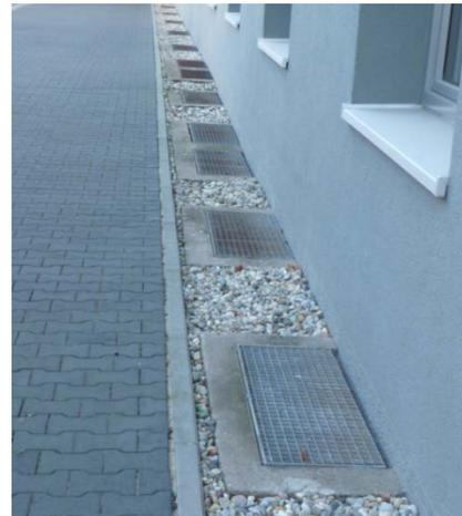
Abbildung 43: In der Realität unterbrechen Lichtschachtwände in regelmäßigen Abständen die Perimeterdämmung
