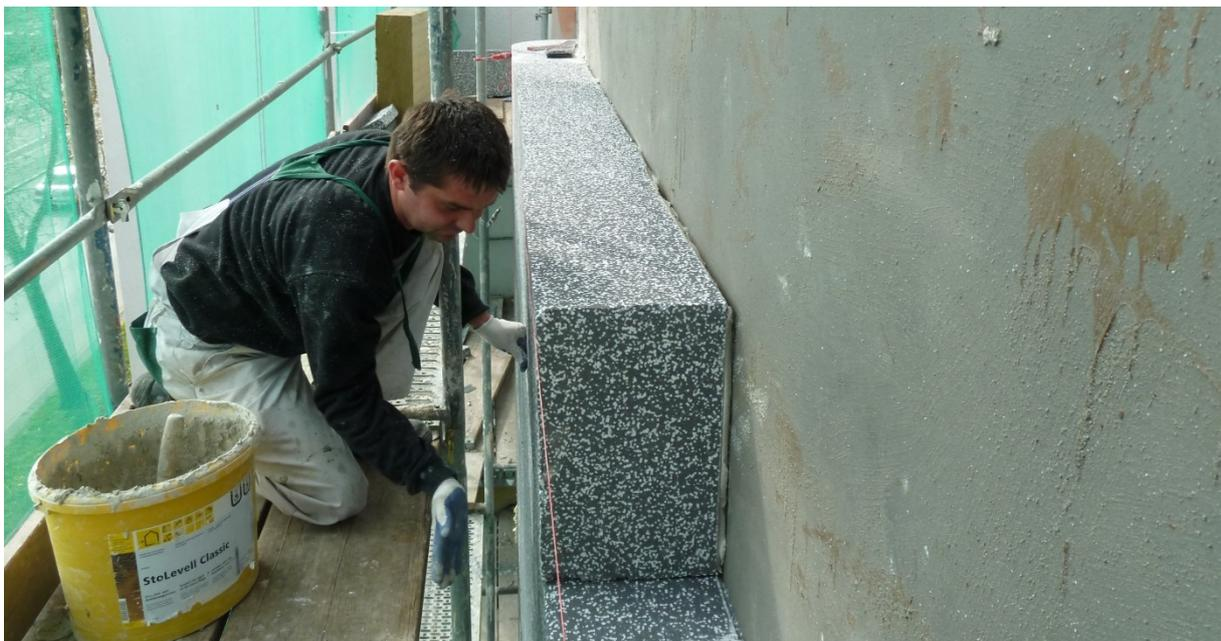
Abbildung 3: Befestigung der 30 cm dicken Wärmedämmung aus Neopor an der Fassade
