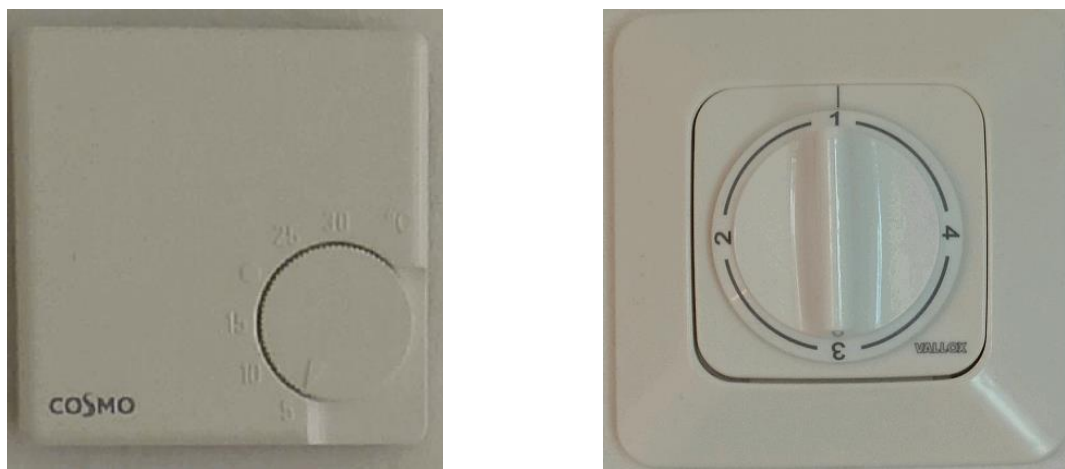
Abb. 8.1: Raumthermostat und Stufenregler der Lüftungsanlage im Wohnzimmer 21
