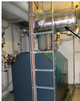
Abb. 4-5: Rußfilter nach der Montage über dem BHKW
