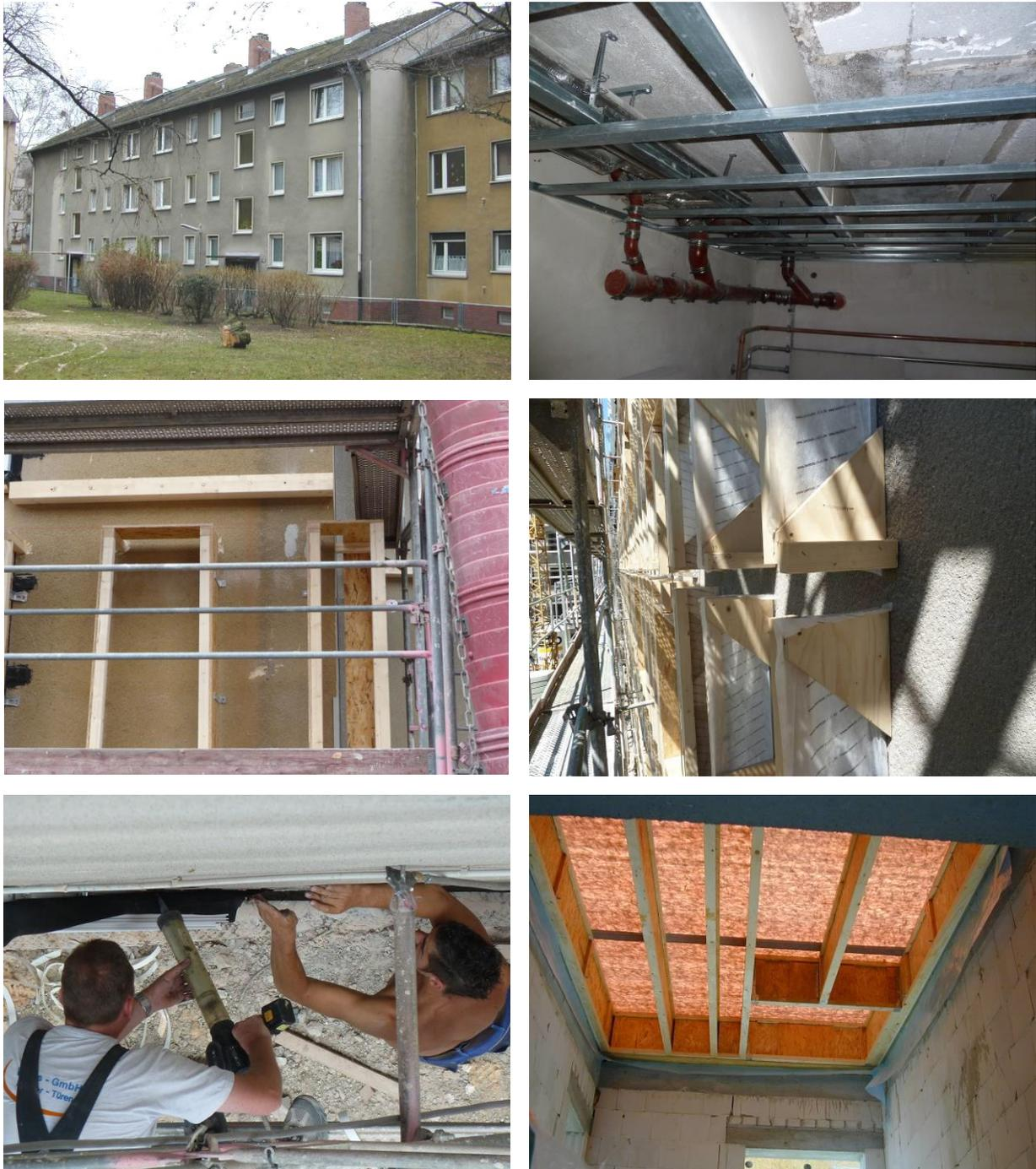
**Abb. 1-2: Ansichten der Gebäude: vor Modernisierung (oben links), Abhängung der Kellerdecke, die später mit Zellulosedämmung gefüllt wurde (oben rechts), Unterkonstruktion der Außenwanddämmung im ersten Bauabschnitt (Mitte links), Unterkonstruktion der Außenwanddämmung auf Höhe der Geschosdecke im zweiten und dritten Bauabschnitt (Mitte rechts), Abdichtung der neuen Passivhausfenster (unten links), Dachkonstruktion im Treppenhauskopf mit 40 cm Holzstegträgern (untern rechts)**
