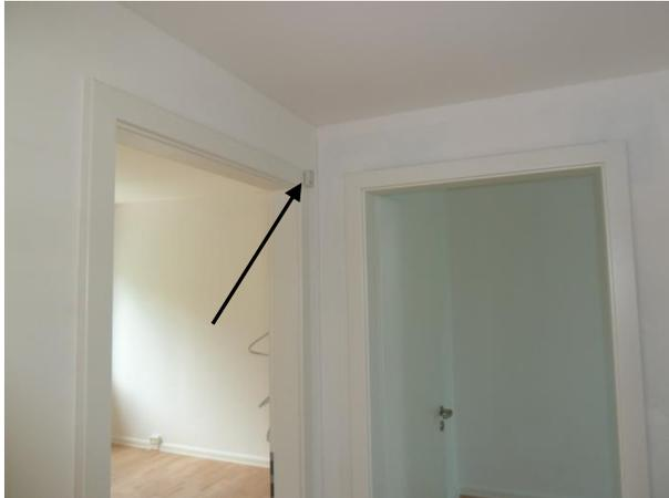
**Abb. 2-2:** Befestigung des Datenloggers in den Bestandsgeschossen auf dem Türrahmen im Flur der Wohnung
