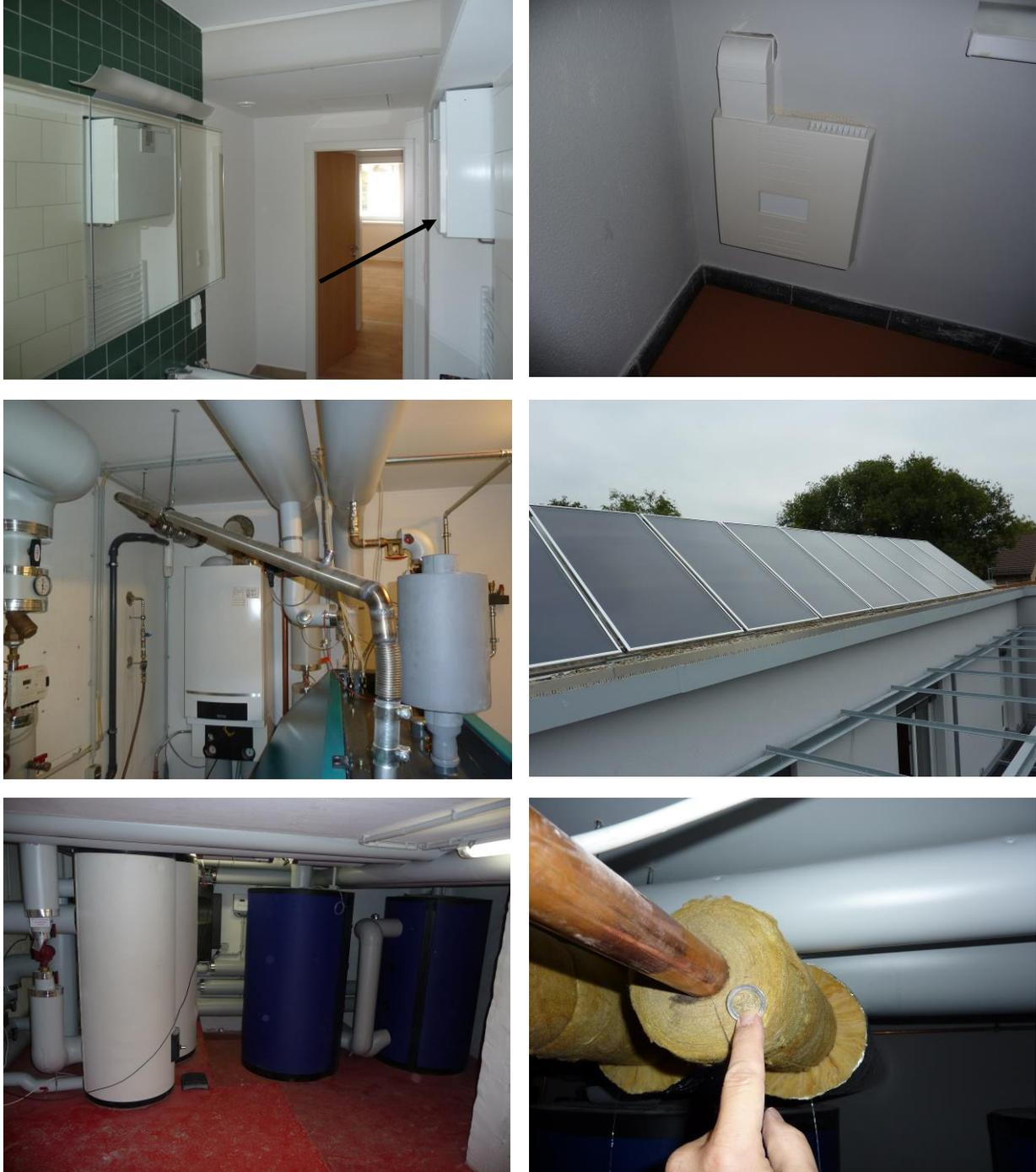
**Abb. 1-3: Ansichten der Anlagentechnik: Lüftungsgerät im Badezimmer (Pfeil, oben links), Lüftungsgerät im Treppenhaus (oben rechts), Heizzentrale mit BHKW vorne und Erdgastherme hinten (Mitte links), thermische Solaranlage auf dem ersten Bauabschnitt (Mitte rechts), Solarpufferspeicher (blau) und Warmwasser-Bereitsschaftsspeicher (weiß, hinten) sowie hydraulische Weiche (weiß vorn) (Bild unten links), zweilagige Verlegung der Leitungsdämmung (Bild unten rechts)**
