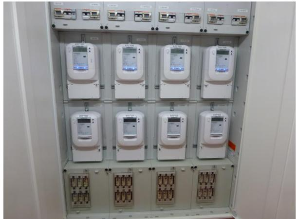
**Abb. 2-5:** Die Haushaltsstromzähler verfügen über Archivregister mit der stündlichen mittleren Leistung, die über Powerline ausgelesen wurden
