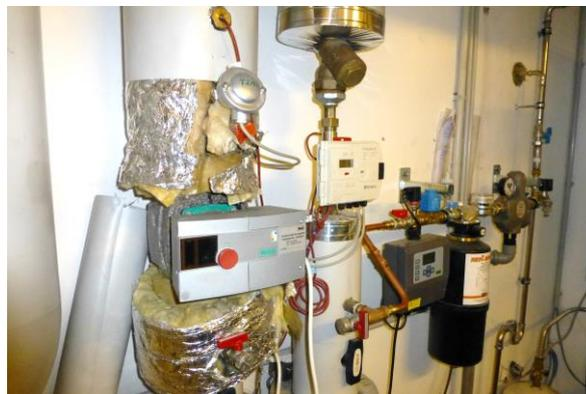
**Abb. 4-1: Pumpe, die nach Montagearbeiten nicht mehr korrekt isoliert wurde (links), ungedämmter Wärmemengenzähler und Schmutzfänger (rechts)**
