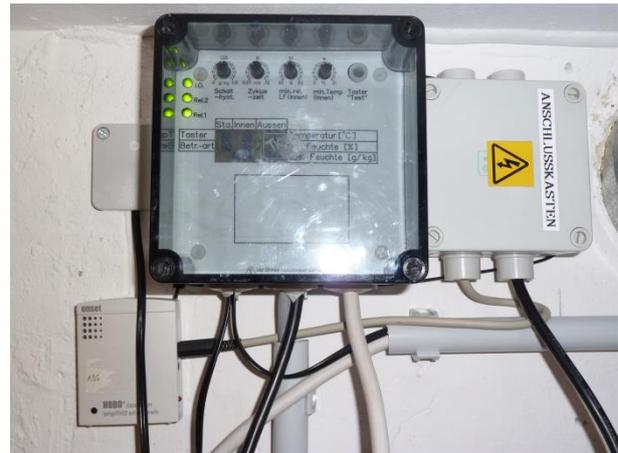
**Abb. 4-44:** Regelung der Kellerlüftung und Messdatenerfassung unter dem Innenfühler der Regelung
