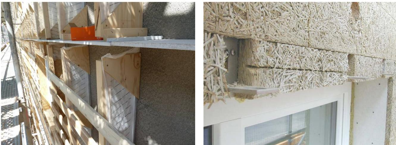
**Abb. 5:** Detailansicht der Trennung der Geschosse mit einer Brandschutzplatte, hier noch ohne Mineralfaserstreifen (links), Haltewinkel für die Schiebeläden, die sich an der Fassadenkonstruktion gut befestigen lassen (rechts)
