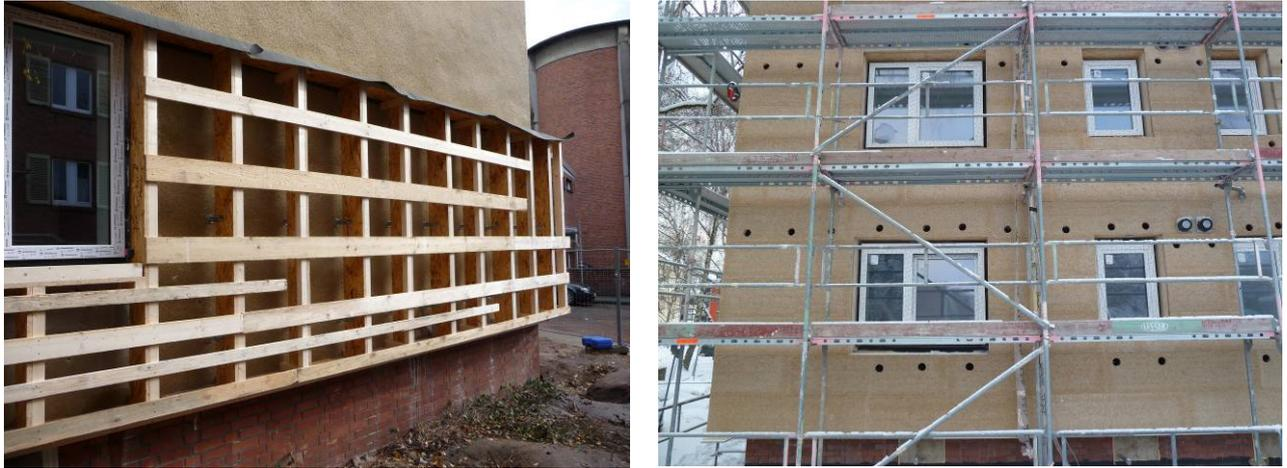
**Abb. 2:** Sparschalung auf der Unterkonstruktion an einer Musterwand (links) als Untergrund für die Holzwoleplatte, die mit Bohrungen zum Ausflocken der Konstruktion versehen wurden (rechts)
