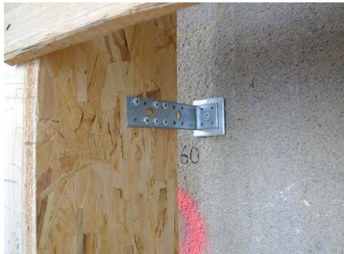
**Abb. 1:** Geschoss hohe Kästen der Fassadenkonstruktion (links), Befestigung der Profile 5 cm vor der Wand mit Metallwinkeln zur thermischen Entkopplung (rechts)
