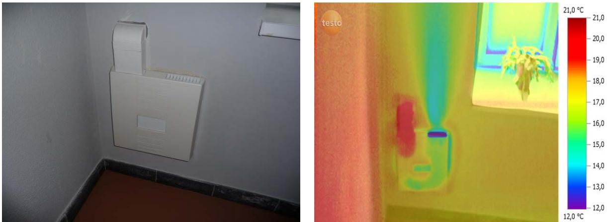
**Abb. 3.2-8:** Einbausituation der Treppenhauslüftung vor dem abschließenden Beiputzen um die Öffnungen (links), Überlagerung von Foto und Innenthermografie beim Lüftungsgerät im Treppenhaus
