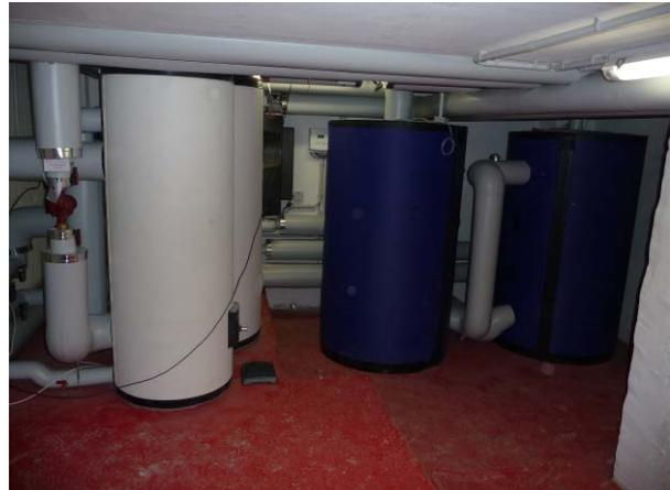
**Abb. 3.2-23: Zwei Solarspeicher mit je 800 Litern Volumen (links), Brauchwasserspeicher (550 Liter + 300 Liter) neben den Solarspeichern (rechts)**
