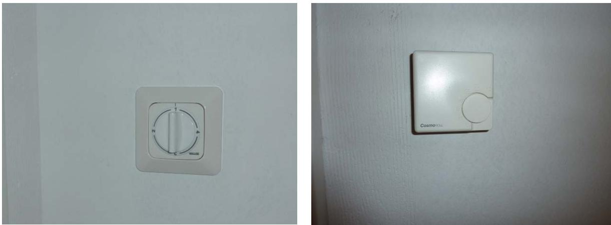
**Abb. 3.2-6: 4-Stufen-Schalter zur Einstellung des Luftaustauschs in der Wohnung (links), Temperatureinstellung über einen thermostatischen Regler (rechts)**
