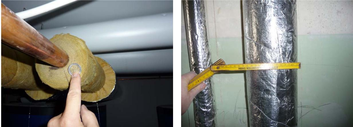
**Abb. 3.2-10: Zweilagige Dämmung der Verteilungen**
