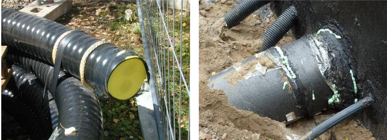
**Abb. 3.2-14: Duo-Nahwärmeleitung (links), verlegte Nahwärmeleitungen mit zusätzlicher Dämmung (rechts)**
