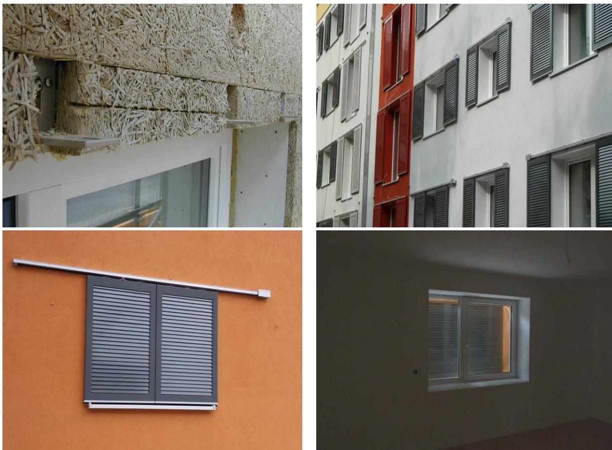
**Abb. 3.1-45: Detailansichten der Schiebeläden: oben links Haltewinkel an der Sparschalung befestigt, die anderen Bilder zeigen Ansichten der Schiebeläden von außen und innen (mit Verdunkelungswirkung bei voller Sonneneinstrahlung)**
