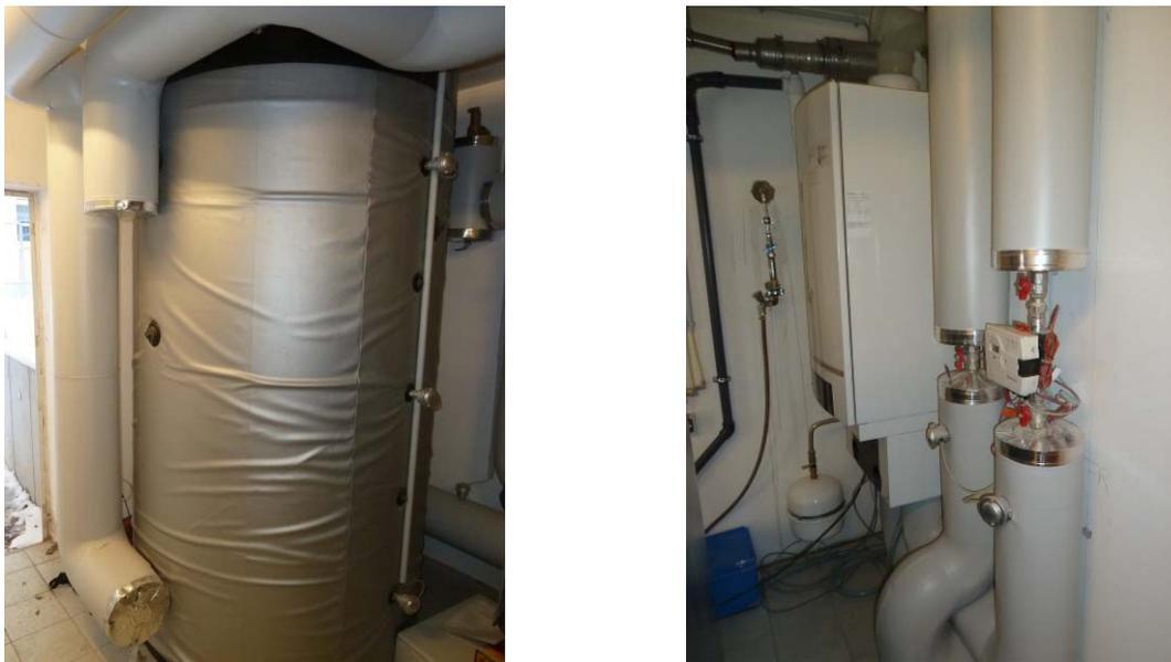
**Abb. 3.2-19: Pufferspeicher im Heizhaus mit 2000 Liter (links), Gastherme (rechts)**
