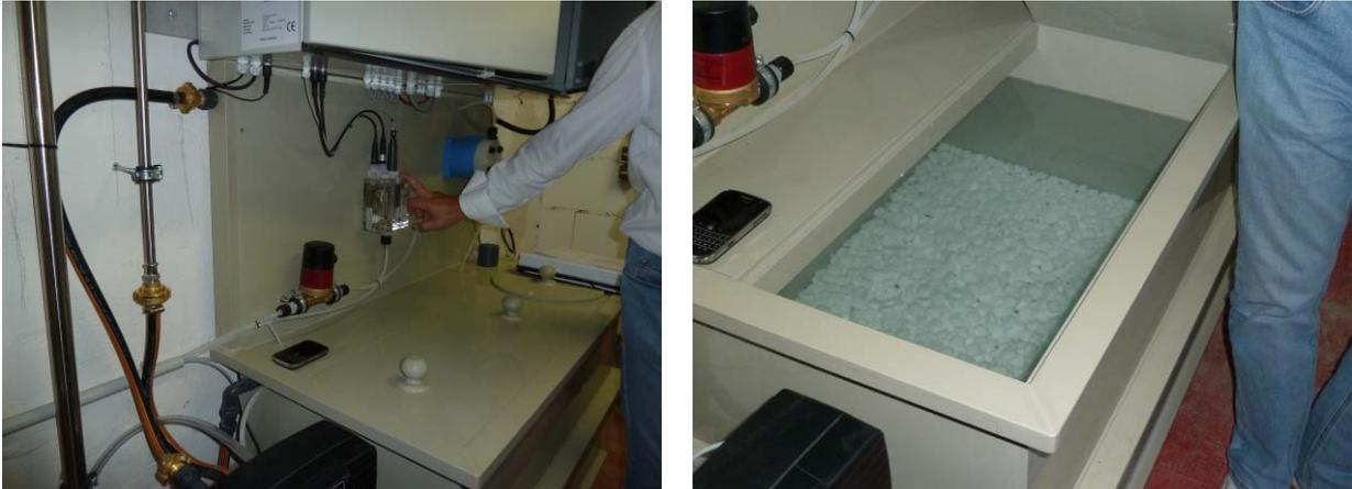
**Abb. 3.2-24: Details der Wasserbehandlungsanlage: links Dosieranlage, rechts Solebehälter**
