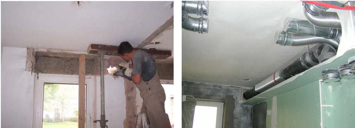
**Abb. 3.2-1:** Abriss der Trennwand zwischen Bad und Küche, im Bild links wird gerade der Durchbruch für die Frisch- und Fortluftleitungen hergestellt; rechts: die Frisch- und Fortluftkanäle werden unter der Decke in einem abgekofferten Bereich verlegt, der anschließend mit Zelluloseflocken ausgeblasen wird
