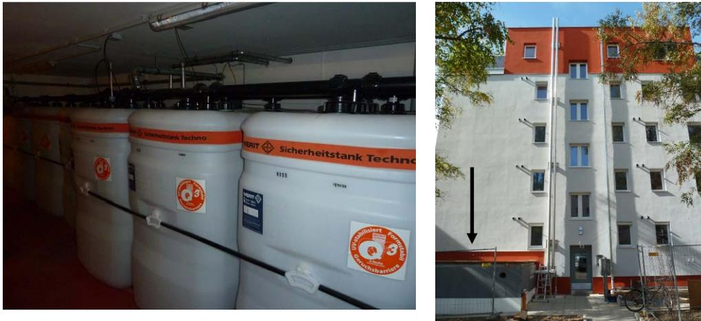
**Abb. 3.2-18: Rapsöllagerung im Keller (links), Heizhaus (Pfeil) mit Abgasanlage (rechts)**
