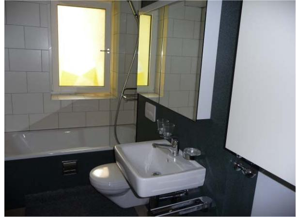
**Abb. 3.2-29: Vorgefertigtes Installationselement und fertiges Badezimmer**
