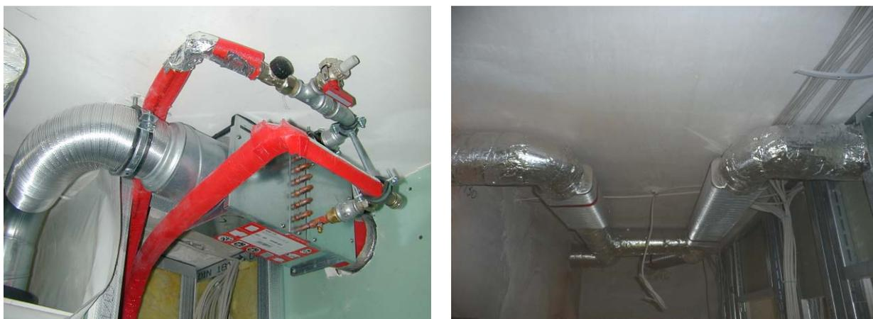
**Abb. 3.2-3: Wasser-Luft-Heizregister der Zuluft im abgehängten Bereich im Bad (links), Verlegung der Lüftungsleitungen im Flur mit flachen Schalldämpfern (rechts)**
