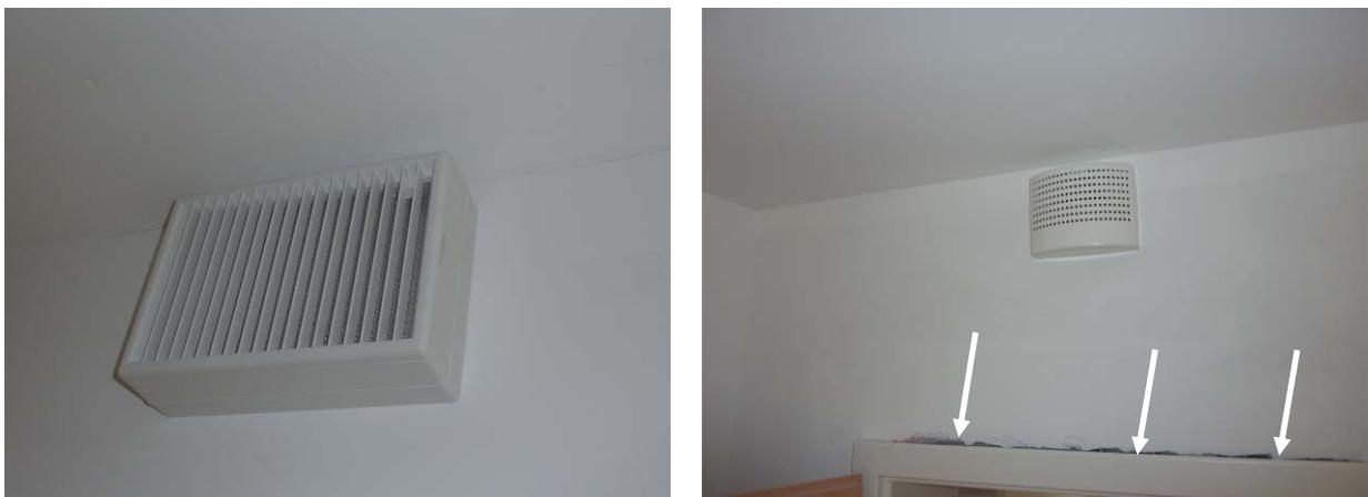
**Abb. 3.2-5:** Abluftventil in der Küche mit einem metallischen Fettfilter (links), Zuluftventil in einem Wohnraum mit Überströmöffnungen (Pfeile) über der Tür (rechts)
