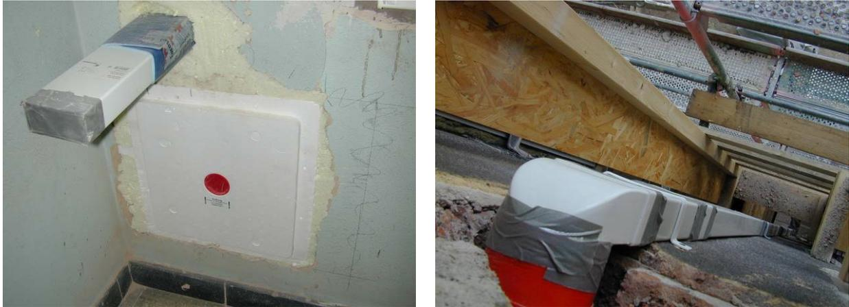
**Abb. 3.2-7:** Formteil für das Lüftungsgerät, das in die Außenwand eingelassen wurde (links), das rechte Bild zeigt den Abluftkanal, der auf der Bestandsfassade vom Dachgeschoss zum ersten Treppenpodest geführt wird
