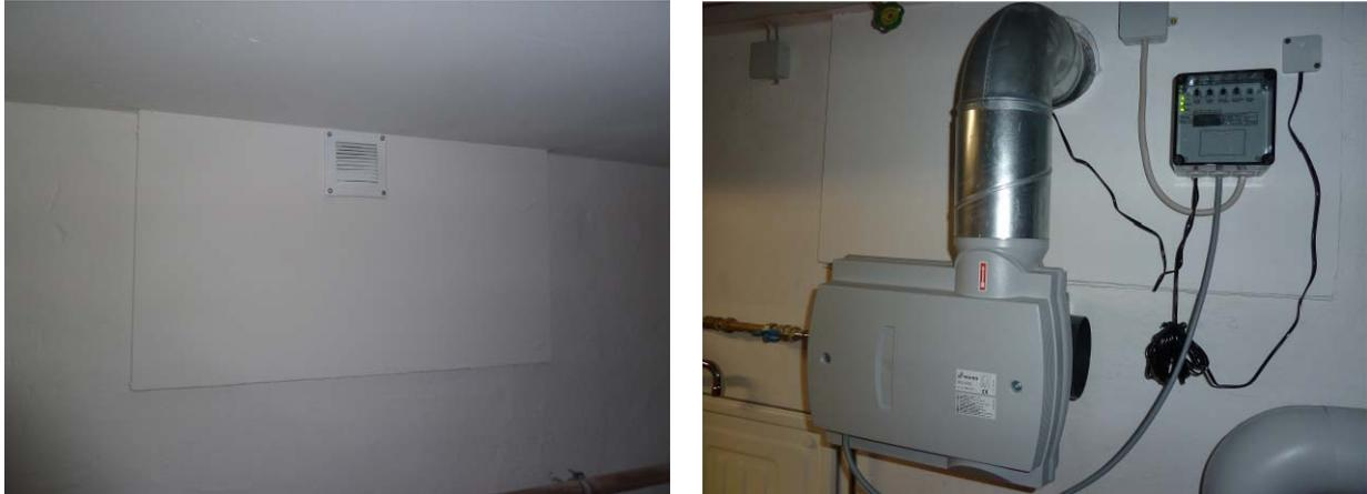
**Abb. 3.2-9: Zuluftelement für die Kellerlüftung (links) und Lüftungsgerät mit Regelung über die Differenz der absoluten Feuchte innen-außen (rechts)**
