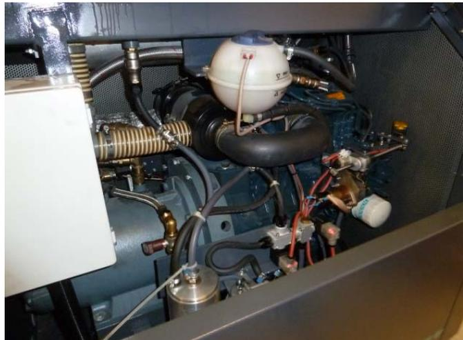
**Abb. 3.2-16: Rapsöl-BHKW im Heizhaus und Blick in das Innere des BHKW**
