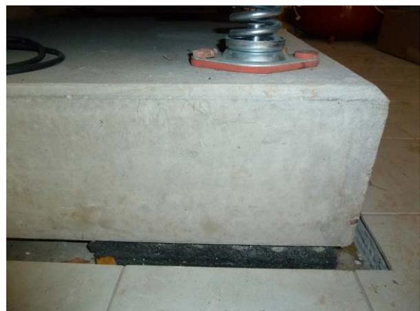
**Abb. 3.2-17: Abgasstrang des BHKW, vor der Dämmung des Rohres und Erdgas-Therme (links), Dämpfer zur Reduktion von Schallübertragungen (rechts)**
