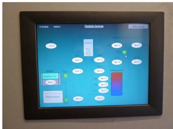
**Abb. 3.2-20: Effiziente Umwälzpumpe und Anlagendarstellung der Regelung**
