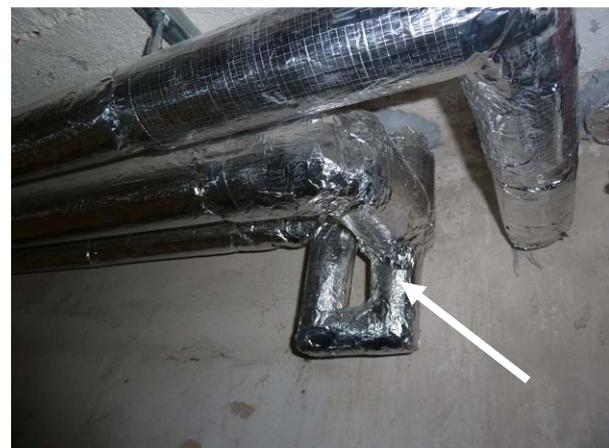
**Abb. 3.2-13: Oberer und unterer Abschluss der vertikalen Zirkulationsleitung**
