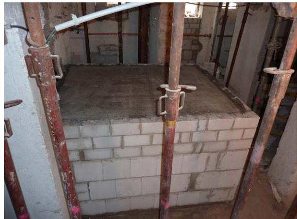
**Abb. 3.2-26: Abbruch des alten Aufzugs (links) und voll ausgedämmter Sockel des neuen Schachtes (rechts)**
