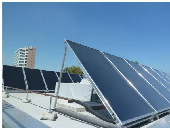
**Abb. 3.2-21: Thermische Sonnenkollektoren auf den Dächern des ersten (links in einer Reihe) und zweiten Bauabschnitts (rechts in zwei Reihen)**
