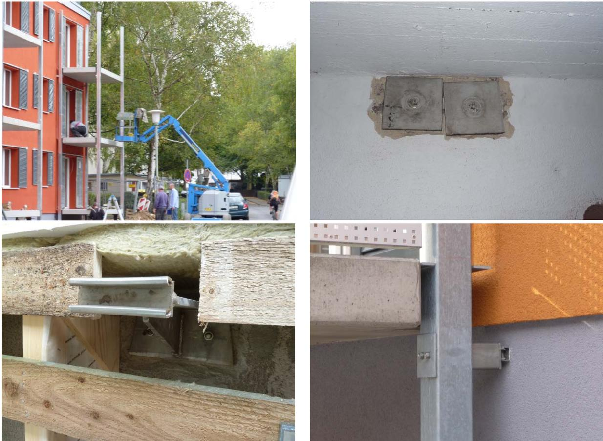
**Abb. 3.1-44: Montage der thermisch getrennten Balkone (oben links) und Ansichten der Halteanker: oben rechts von innen, unten links von außen während der Bauphase, unten rechts mit fertig montiertem Balkon**
