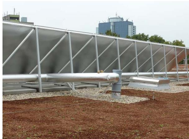
**Abb. 3.2-22: Dämmung der Solarleitungen und Durchführung durch das Flachdach**
