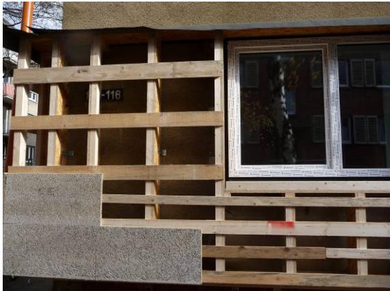
**Abb. 4.1-1: Ansicht der Fassadenunterkonstruktion an der Gebäudeecke mit Fenster, links Bekleidung der Unterkonstruktion durch Holzspan-Platten**
