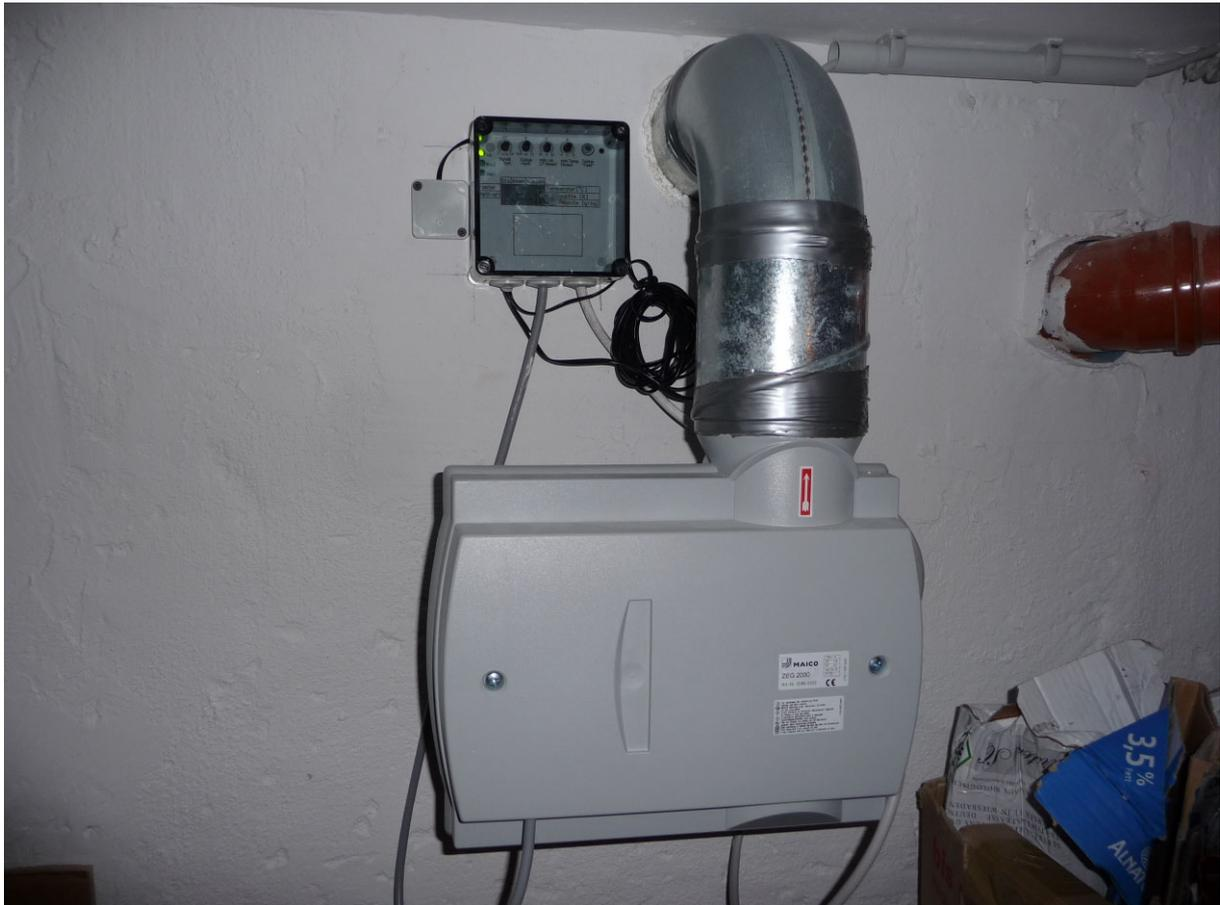
**Abb. 4.4-7: Ansicht des Ventilators im Keller und der Feuchte-Regelung**
