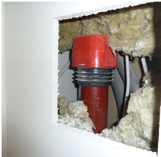
**Abb. 4.3-2: Innen liegender automatischer Fallrohrentlüfter in der Wohnung am oberen Ende des Fallrohrs**
