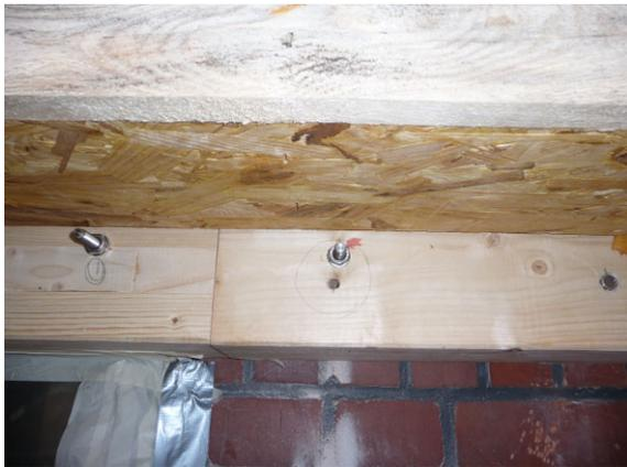
**Abb. 4.1-3: Befestigung des unteren horizontalen Trägers an der Geschosdecke (Blick von unten gegen Horizontalträger und Abschluss Gefach)**
