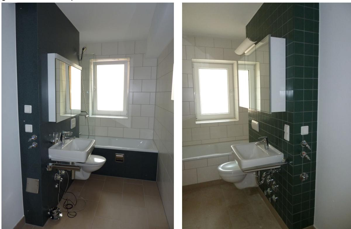
**Abb. 3.3-1: Blick in das Badezimmer: links Ausführung im ersten Bauabschnitt mit Corian-Platten, rechts Ausführung zweiter / dritter Bauabschnitt mit Fliesen**
