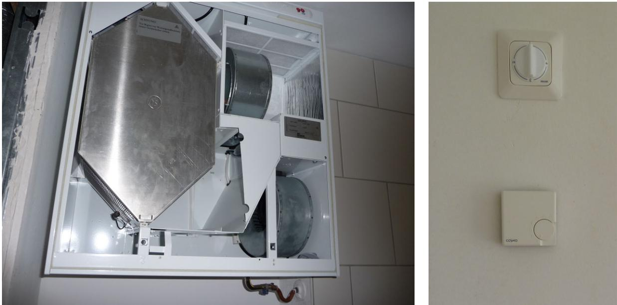
**Abb. 4.4-1: Ansicht des geöffneten Lüftungsgerätes im Badezimmer (links) und des Lüftungswahlschalters sowie des Temperaturreglers im Wohnzimmer (rechts)**
