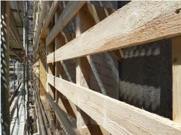
**Abb. 4.1-18: Sparschalung auf der Fassade vor Montage der Heraklith-Bekleidung**
