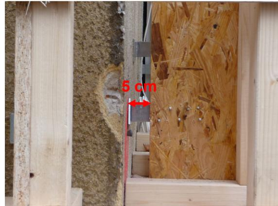
**Abb. 4.1-2: Detail der Befestigung der OSB-Platten mit 5 cm Abstand vor der Bestandsfassade durch Metallwinkel**
