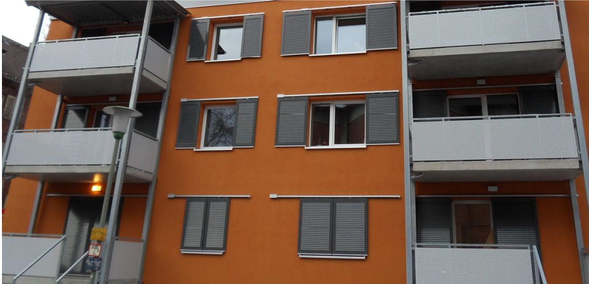
**Abb. 3.3-2: Ansicht der elektrisch betriebenen Schiebeläden für Verdunklung und Verschattung der Süd-, West- und Ostfenster im Bestandsgeschoss**
