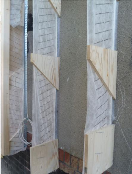
**Abb. 4.1-16: Ansicht Konsolen, Befestigungsschiene sowie Trennbahn**
