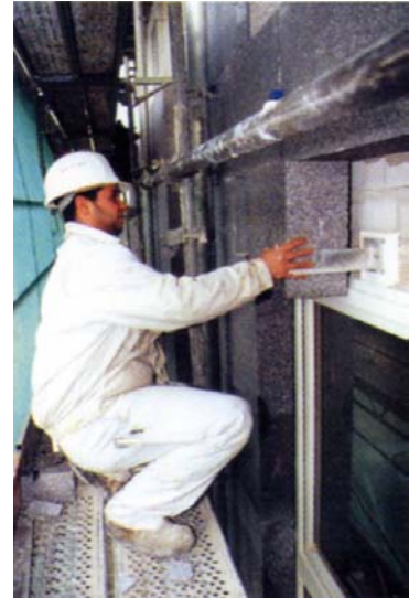
Abb. 2.6: Montage des Wärmedämm-Verbundsystems: Erkennbar ist eine der punktuellen Verankerungen des vorgeständerten Balkons
