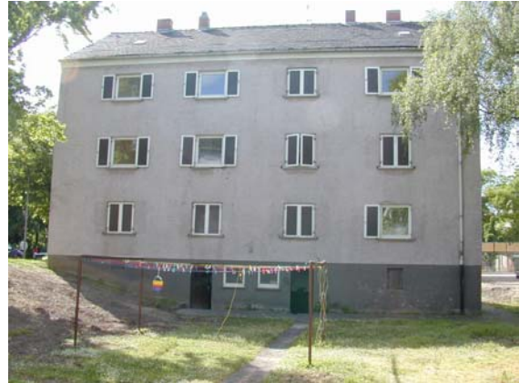
Abb. 2.2: Typisches Gebäude aus dem Brunckviertel vor der Modernisierung
