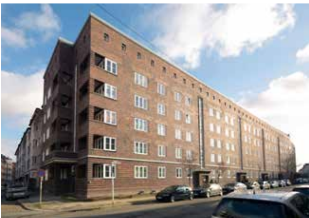
Wohnblock mit BHKW der STÄWOG Bremerhaven (© STÄWOG)
