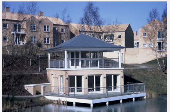
Siedlung Sandbakken in Aarhus
