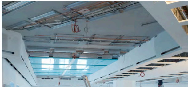
Unterkonstruktion der Heiz-/Kühldecken mit Aktivierungsprofilen
