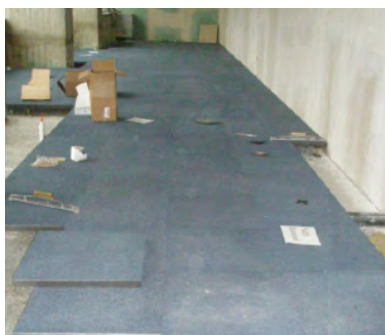
Ausbau auf der Baustelle
