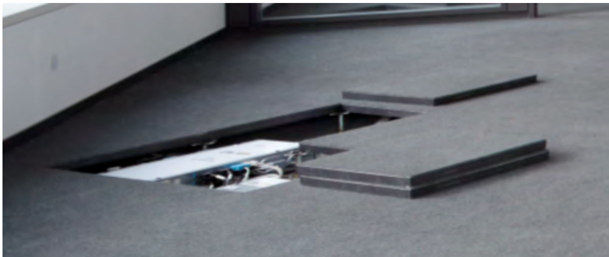
Fußboden als Doppelboden-Konstruktion mit Kalziumsulfatplatten auf Unterkonstruktion (Metallrahmen und -stützen)
