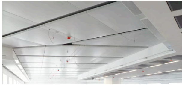
Heiz-/Kühldecken mit Graphit-Elementen im verkleideten Zustand
