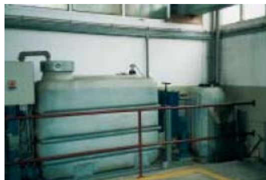
Abb. 2.2-6: Speicher Buswaschanlage
