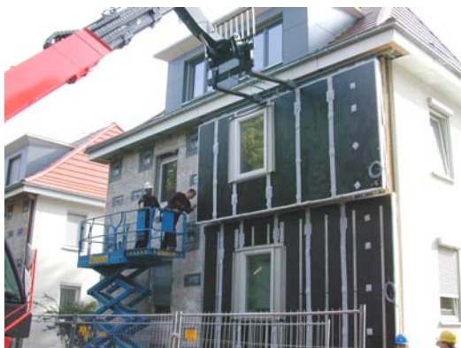
Foto: Installation der Großdämmelemente
