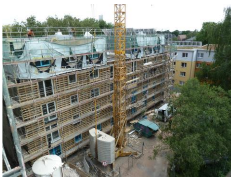
Foto aus der Bauphase: Gebäude mit montierter Unterkonstruktion für die Fassade aus nachwachsenden Rohstoffen
