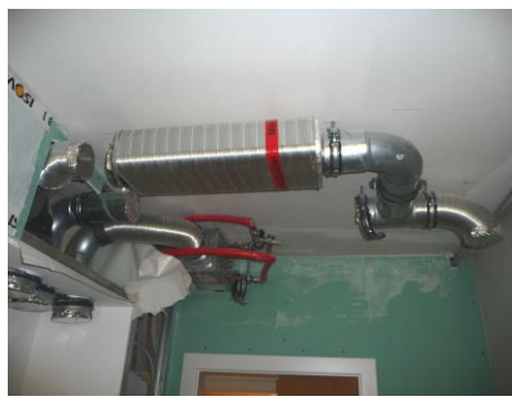
Montage der Lüftungsanlagen mit Wärmerückgewinnung in einer abgehängten Decke im Badezimmer
