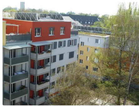
Ansicht des zweiten Bauabschnitts mit den thermischen Solaranlagen
