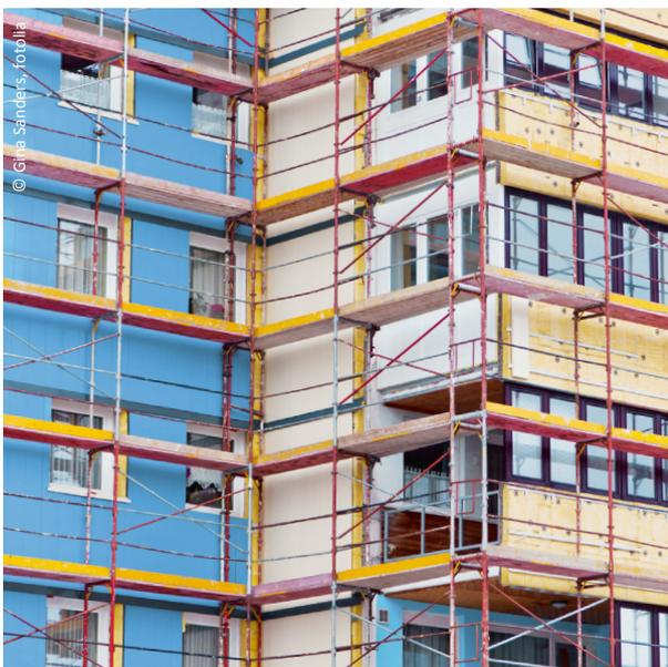
Steigerung der Energieeffizienz durch Außenwanddämmung
