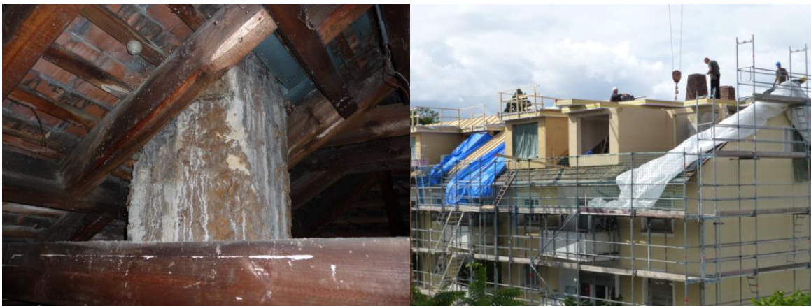
Abbildung 3: Ein vorher nicht ausgebauter Dachstuhl (links), der nach Dachausbau (rechts) und energetischer Dämmung zukünftig als Wohnraum genutzt wird.
