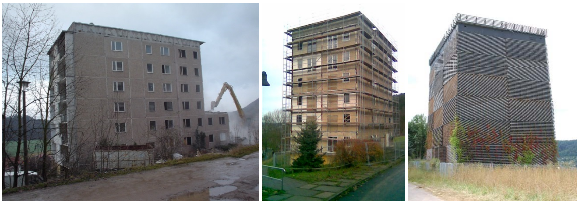
Abbildung 6: Umbau eines nicht mehr genutzten Plattenbaus zum Fledermausturm Meiningen
