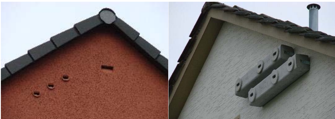
Abbildung 4: integrierte Quartiere für Mauersegler und Fledermäuse (links) und Mauerseglerkästen Fotos: Jürgen Albrecht, Bildquellen: Stadt Gütersloh, Umweltportal , letzter Aufruf am 26.01.2016.
