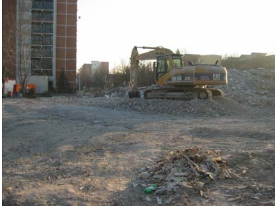
Abb. 2: Abriss von Plattenbauten in Dresden-Prohlis (Foto: R. Bendner)
