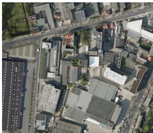
Geringe Bebauung mit überwiegender Nutzung durch Gewerbe und Industrie: ein- bis zweigeschossige Hallen- und Gebäudekomplexe; Bebauung unter 50 %; typischer Freiraum: große Abstandsflächen, meist als Lager- oder Parkplatz genutzt
