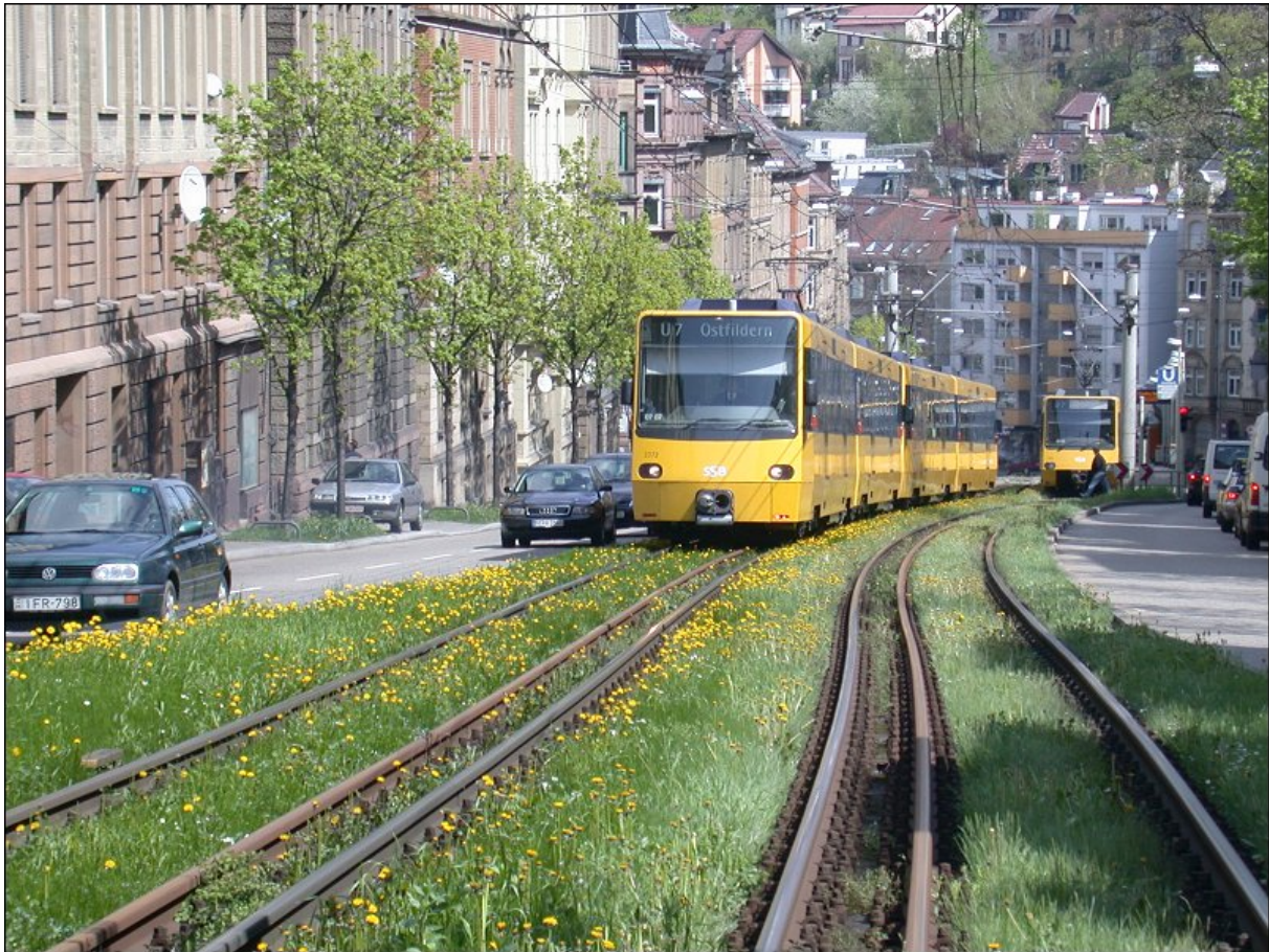
Abb. 7: Rasenbahnkörper der Stadtbahn in Stuttgart
