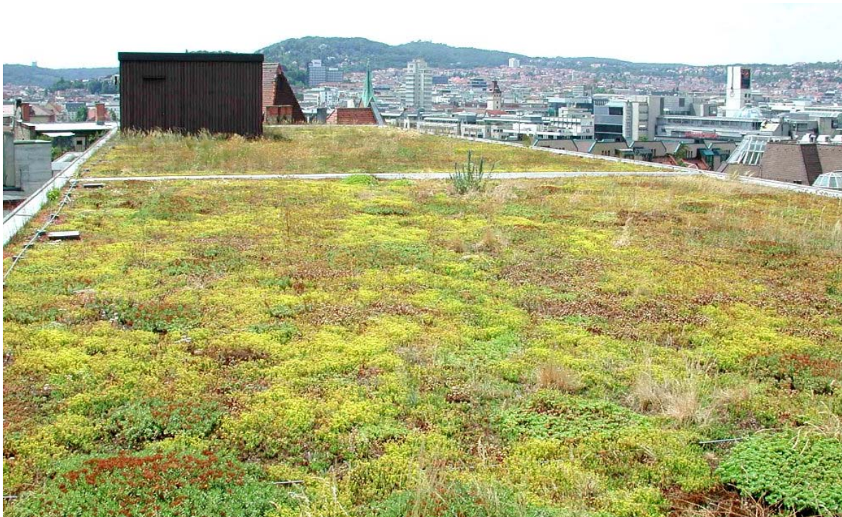
Abb. 8: Extensiv begrüntes Dach als thermisch ausgleichende Fläche, Stuttgart
