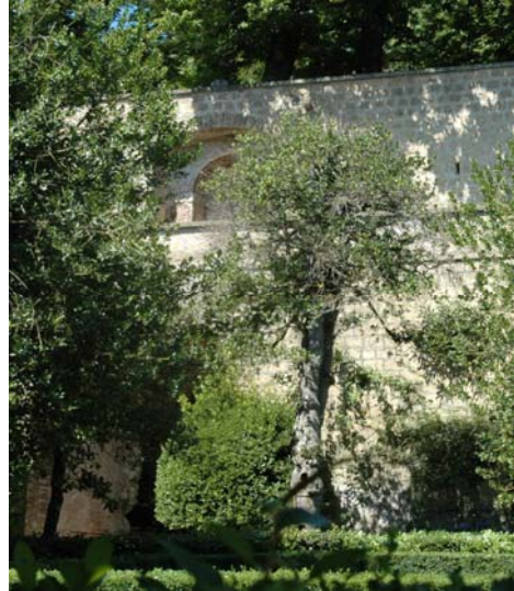
Abb. 5: Stützmauer mit Sonnenterrasse an der Nordwestseite des Wintergartens der Villa Farnese, Caprarola
