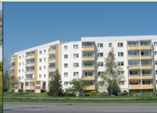
Energetisch sanierte Wohnungen
