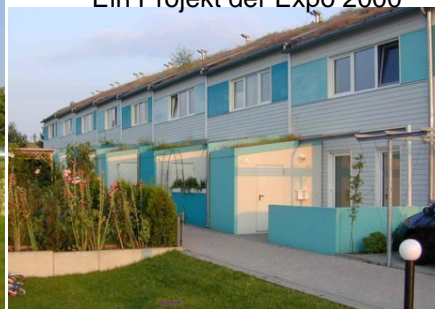
Ansicht Eingangsseite - Nord
