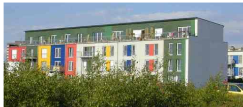
Gesamtansicht von Westen
