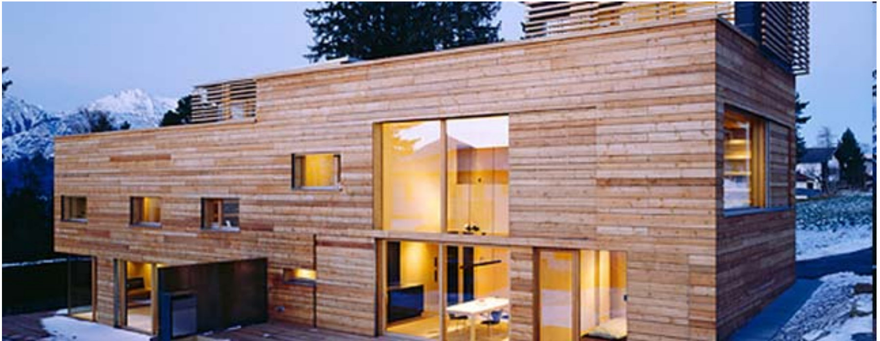
Wohnhaus Hammerer (Sistrans)
