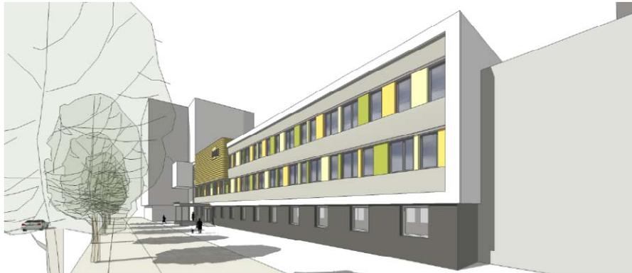
Sanierung mit passivhaustauglichen Komponenten gemäß Förderprogramm des Landes Hessen: Zielwert  $25 \text{ kWh/m}^2_{\text{EBFa}}$
