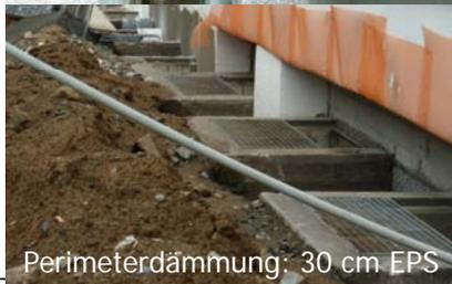
Perimeterdämmung: 30 cm EPS
