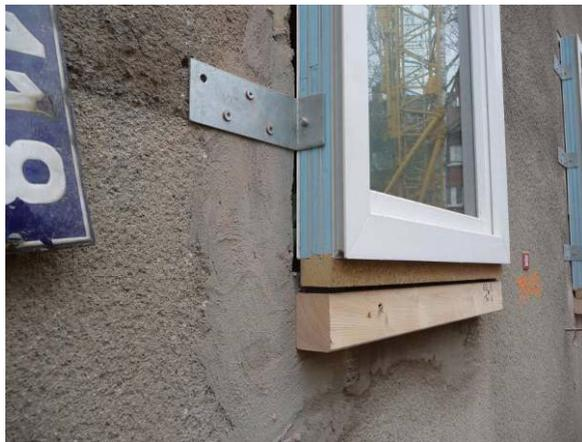
Montage der Passivhaus-Fenster vor die Bestandswand mit thermischer Trennung an der Fensterbank durch Purenit (zw. Fenster und Setzholz)
