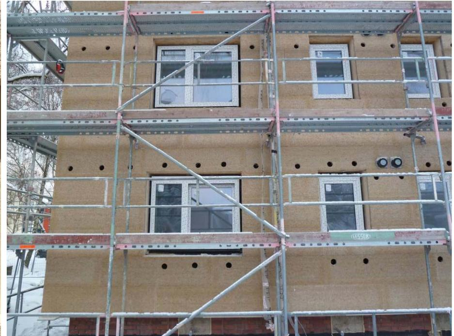
Auf die Sparschalung werden magnesitgebundene Holzwoleplatten (3,5 cm dick) als Putzträger montiert. Durch die Bohrungen werden die Gefache mit Zellulose ausgeblasen
