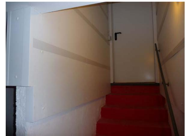
Dämmung Abgang Kellertreppe und der Unterseite der Treppe zum EG mit PU-Platten (4/8 cm)
