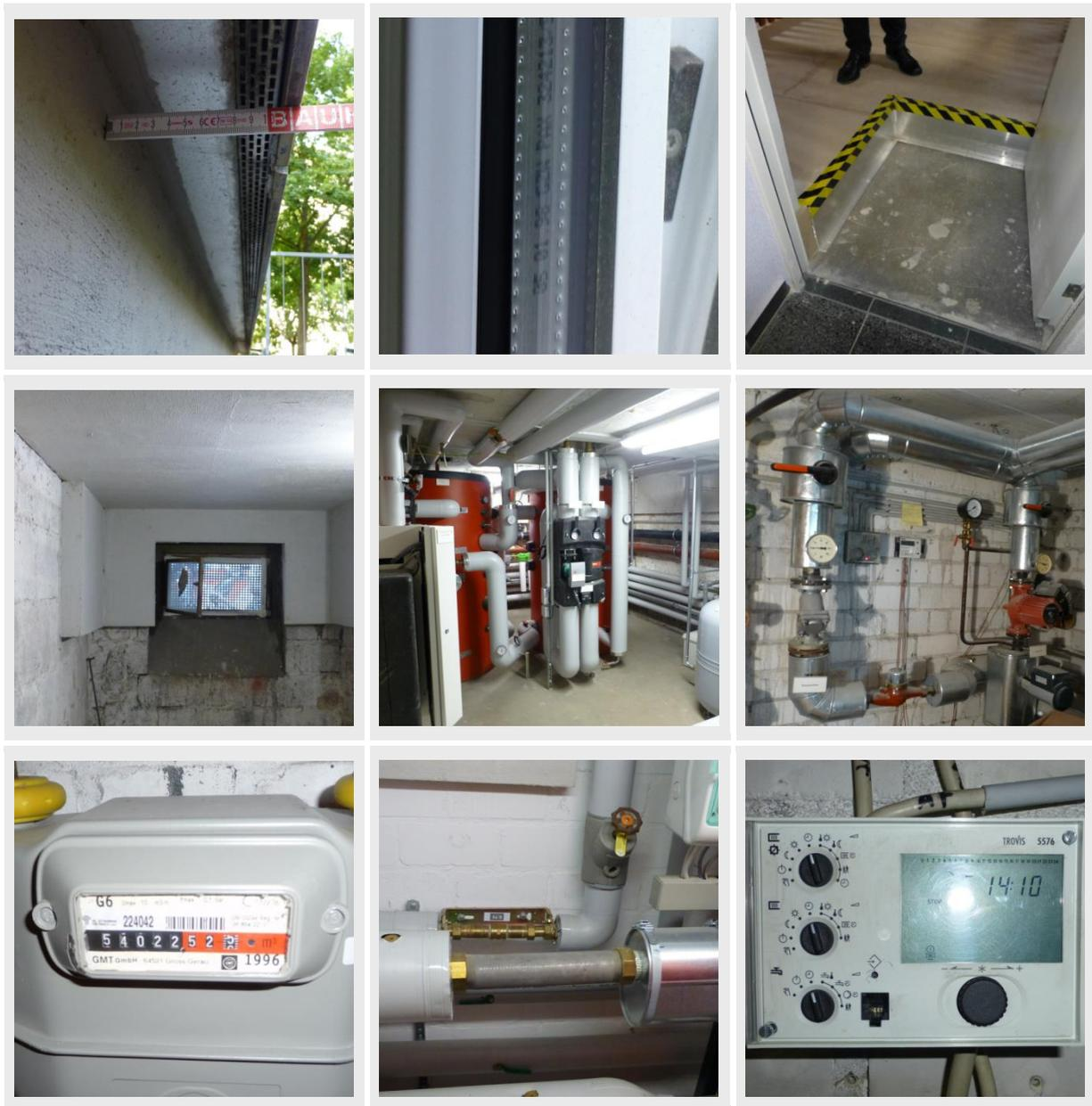
**Bild 5: Fotos von der Vor-Ort-Überprüfung des Wärmeschutzes, der Anlagenkonfiguration, der Leitungsdämmung, der Zählermesstellen und der Regelungseinstellungen**
