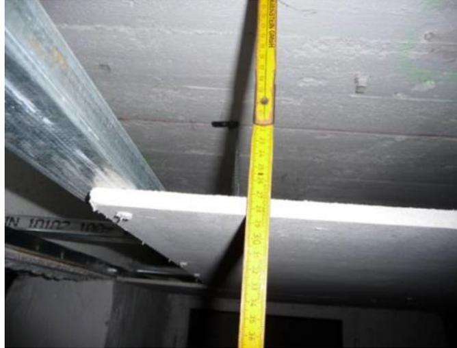
Verkleidung mit Gipsfaser-platten, so dass ein Hohlraum von 26 cm entsteht, der mit Zelluloseflocken ausgeblasen wird
