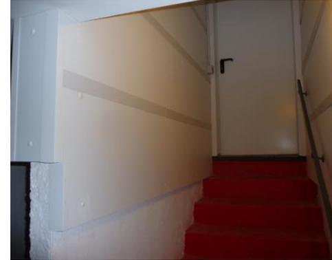
Dämmung Abgang Kellertreppe und der Unterseite der Treppe zum EG mit PU-Platten (4/8 cm)
