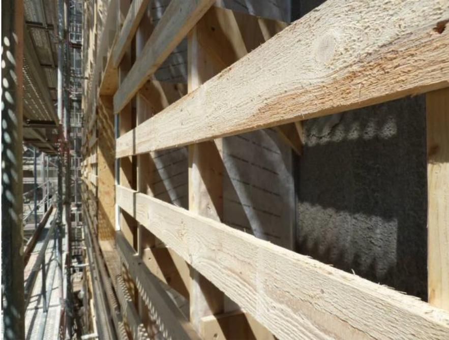
Eine Sparschalung bildet den Untergrund für die Putzträgerplatten
