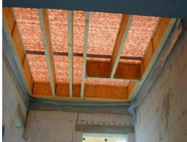
Treppenhaus mit Konstruktion des Daches aus TJI-Trägern, bevor sie mit einer OSB-Platte geschlossen und mit 40 cm Zellulose ausgeblasen wurde
