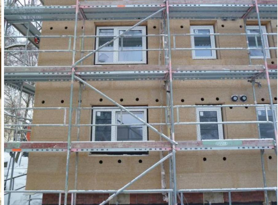
Sparschalung und magnesit-gebundene Holzwolleplatten (3,5 cm dick) als Putzträger montiert.
